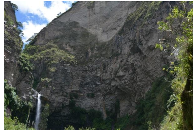
Talud zona del puente
