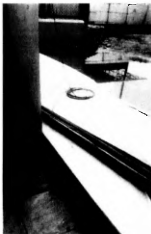
c) Desmontaje de cubierta de policarbonato.
