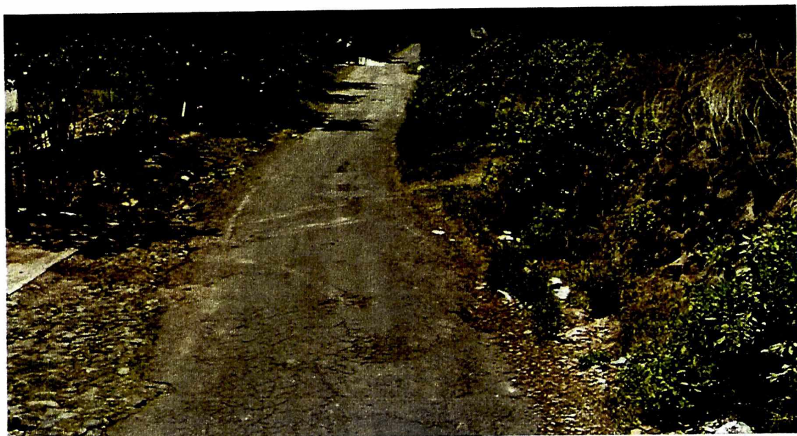
Imagen 3. Calle Quito (Tramo 2, Empedrado)
