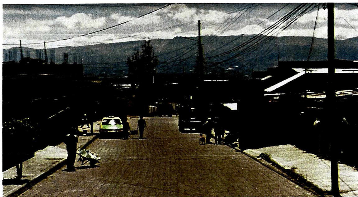
Imagen 2. Calle Quito (Tramo 1, Adoquinado)
