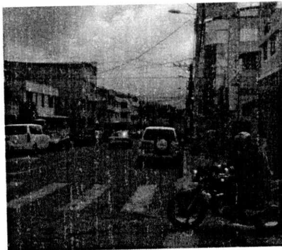
Foto 2. Calle Luis Urdaneta, sentido norte - sur.
