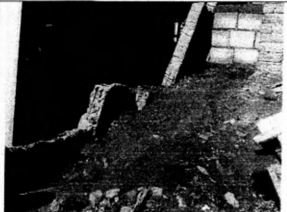
Reconformacion talud lado norte
