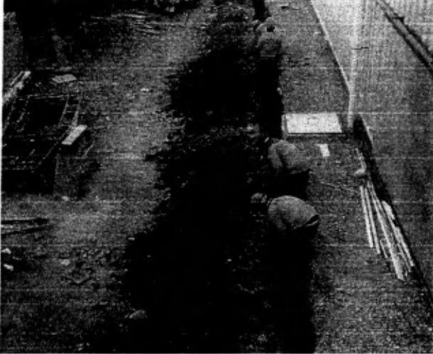
Acera y bordillo exterior faltante lado este.
