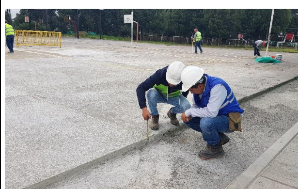
Foto 1.- 08/08/17- Verificación de juntas
