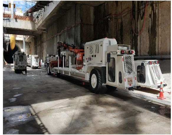
Foto 2.- 04-08-2017. Contrabóveda, aparcamiento de trackless.
