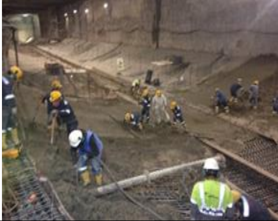
Foto 1.- Vaciado de hormigón en contrabóveda Fase 4
