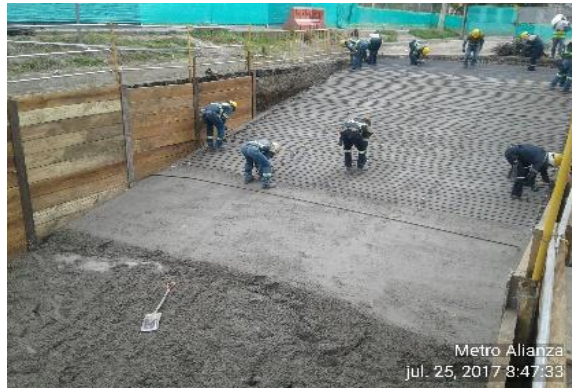
Foto 3.- 25/07/2017. Inicio de armado de losa de muro en U en calle Sodiro
