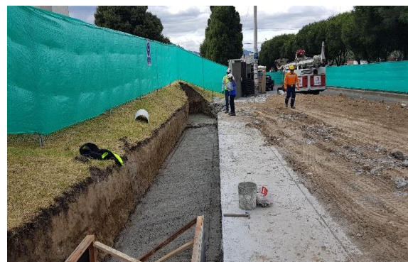
Foto 2.- 09/08/17 - Replantillo de la viga
