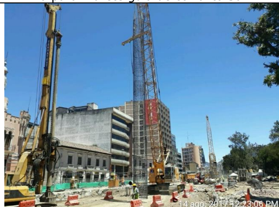
Foto 10.- 14/08/2017. Izaje de armadura de pilote #246.
