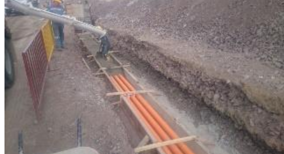
Foto 4.- Zanja de enclavamiento y señalización
