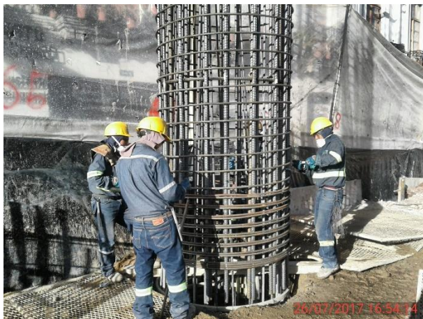
Foto 3.- 26/07/2017. Colocación, trasape y sujeción de armadura.
