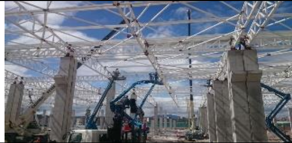
Foto 2.- Colocación de estructura metálica
