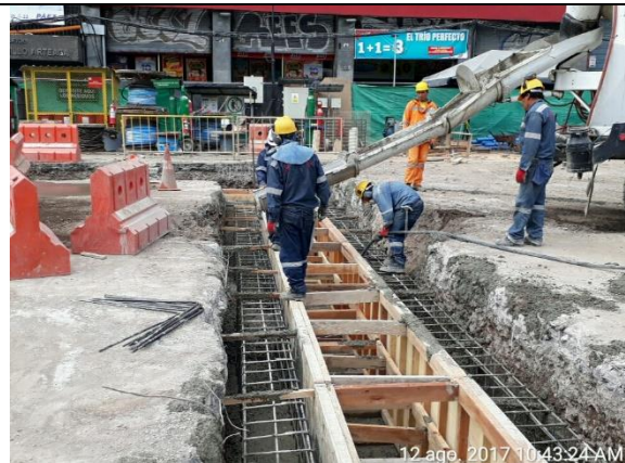
Foto 8.- 12/08/2017. Vaciado de hormigón de 21 MPa para murete guía de corralito Sur.
