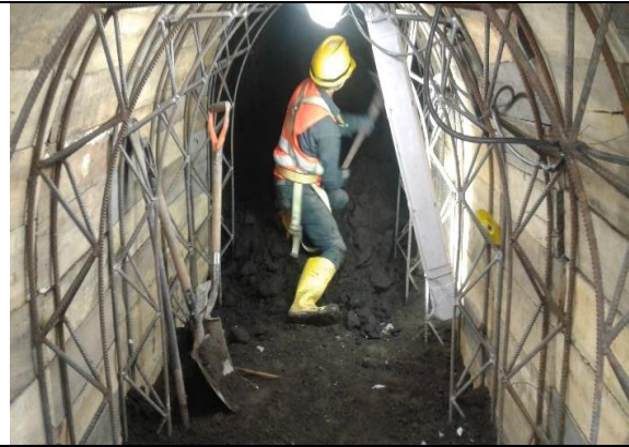
Foto 6.- Construcción de galería para paso de tubería de 400mm
