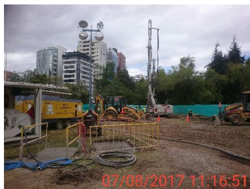
Foto 2.- Tratamiento de terreno.
