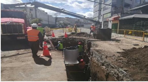
Foto #3: 22/07/2017. Ejecución de pozos de revisión de la red de alcantarillado auxiliar, fase 1, estación La Pradera
