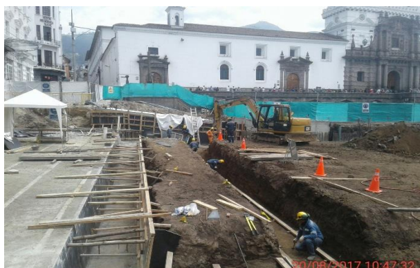
Foto 9.- 20/08/2017. Excavación y encofrado de vigas V1 y V2
