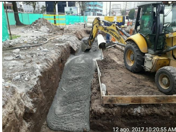
Foto 7.- 12/08/2017. Vaciado de replantillo para murete guía de pilotes de Acceso 2.
