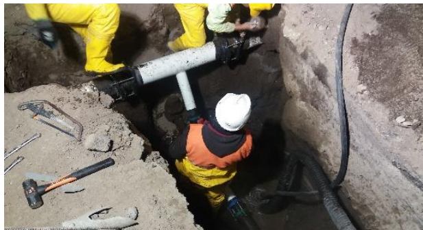
Foto #2: 30/07/2017. Interconexión de tuberías de agua potable, fase 1, estación La Pradera.
