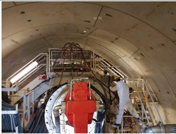
FOTO 01: 25/07/17 – Mantenimiento y limpieza de equipos.
