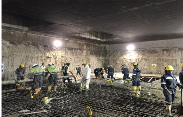
Foto 5.- Hormigonado de la losa de vestíbulo fase 1 y 2
