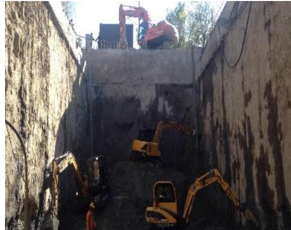
Foto 4.- Excavación de la fase 7 de contrabóveda
