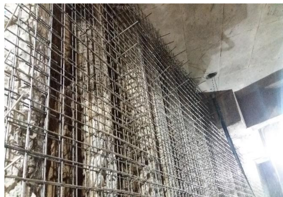
Foto 1: Armadura estructural de muro forro.
