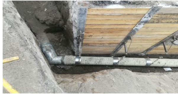
Foto #4: 25/07/2017. Ejecución de colectores de alcantarillado, fase 1, estación La Pradera
