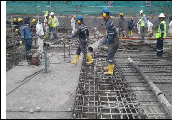
Foto 5.- Vaciado de hormigón en vigas (V1-V7)
