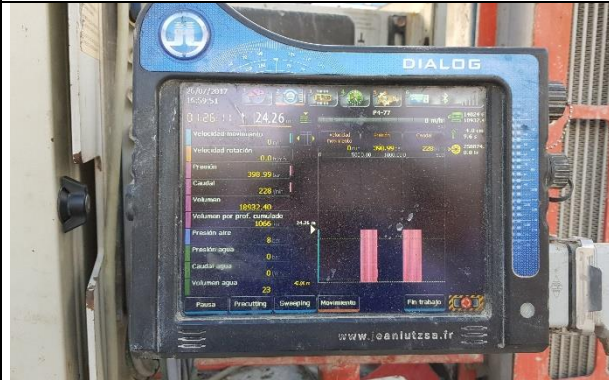
Foto 3.- 26/07/17 Verificación de los parámetros de perforación e inyección
