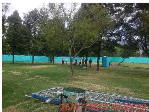
Foto 1.- Adecuamiento de sitio de obra.
