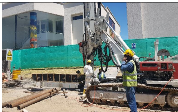
Foto 3.- 15/08/17 - Realización de micropilotes
