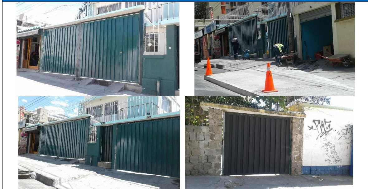
Colocación de puertas basculantes metálicas.
