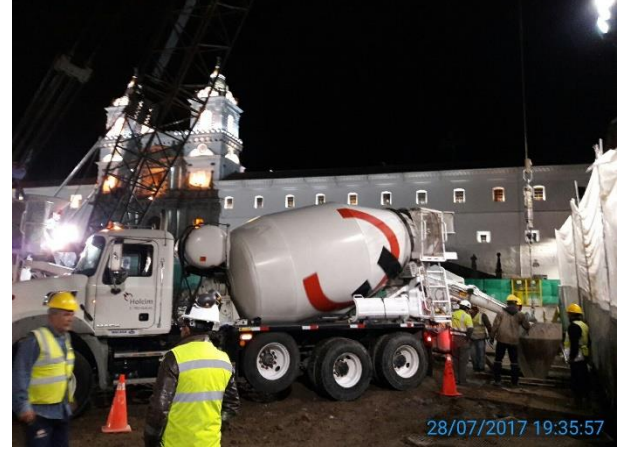
Foto 4.- 28/07/2017. Vaciado de hormigón en pilote.
