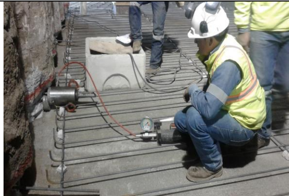
Foto 4.- Ensayo de extracción de anclajes
