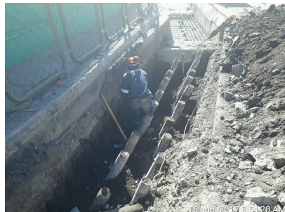
Foto 2.- 16/08/2017. Excavación a nivel de cota inferior de viga de amarra.
