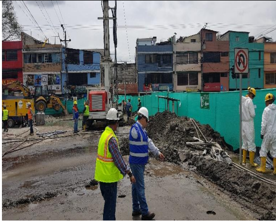
Foto 1.- 08/08/17- Verificación de trabajos
