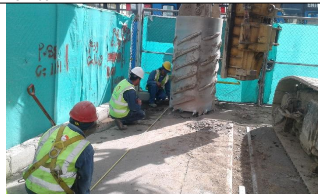
Foto 4.- Perforación de Pilotes
