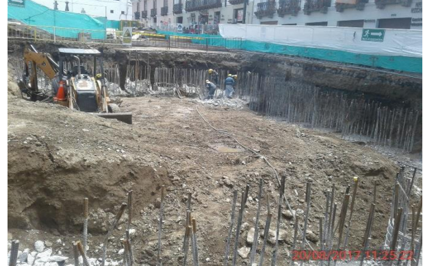
Foto 9.- 20/08/2017. Descabezado y limpieza de pilotes, excavación de plataforma a nivel de losa de cubierta
