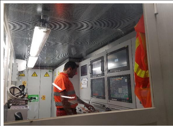
FOTO 2: 03/08/17- Operador verificando la presión de tierra.
