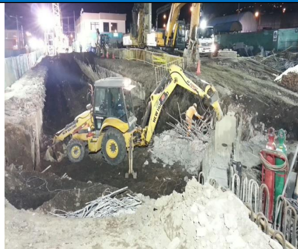
Foto 1. Descabezado de Pantallas
