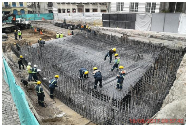
Foto 9.- 18/08/2017. Acero de refuerzo de vigas y losa inclinada.
