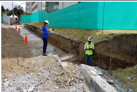
Foto 1.- 07/08/17- Realización de viga de atado de la pantalla
