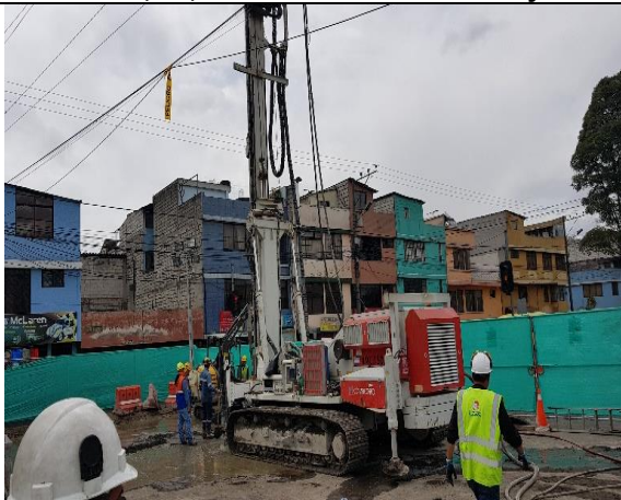
Foto 3.- 11/08/17 - Perforación e inyección de jet Grouting.
