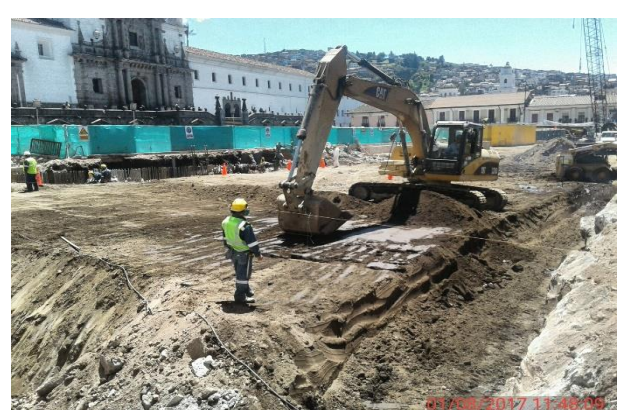
Foto 6.- 01/08/2017. Excavación en suelo a nivel de vigas
