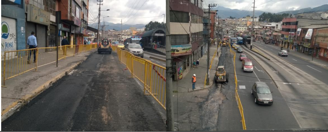
Foto 3 y 4.- Reposición de pavimentos y asfaltado
