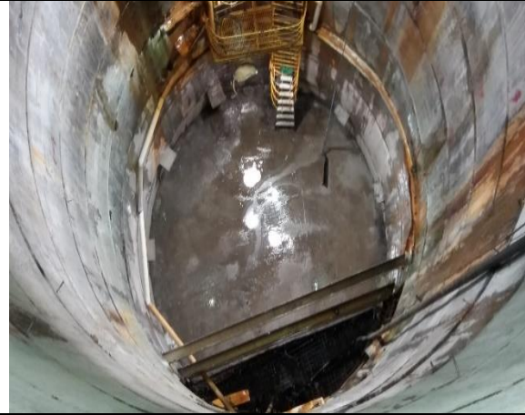
Foto 4.- Desencofrado de anillo #12.
