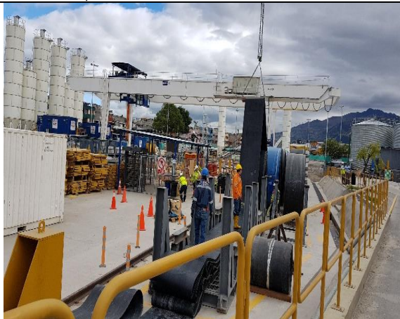
Foto 5.- 09/08/17 Empalme de cinta transportadora
