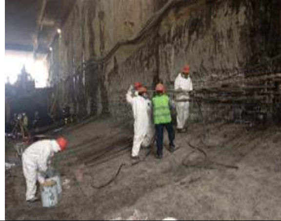
Foto 2.- Instalación de anclajes Ø 32 para anclaje tipo disposición A en la Fase 6 de la contrabóveda.
