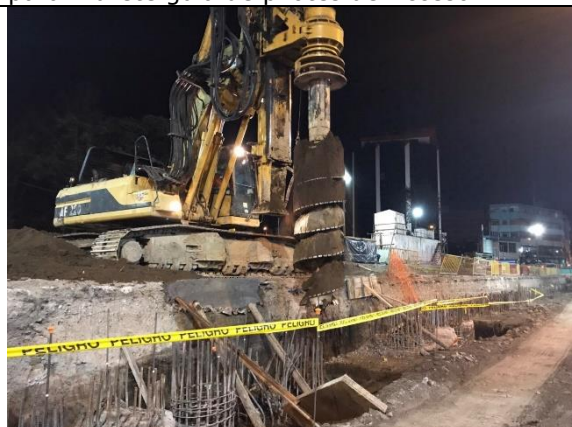
Foto 9.- 14/08/2017. Perforación de pilote #246.
