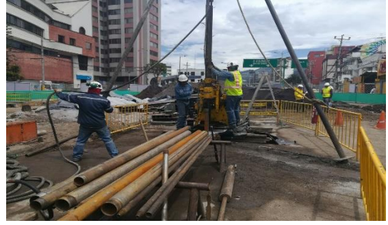
Foto 2.- Perforación de pozo para monitoreo ambiental. Profundidad 29,5m. Pozo #N2.
