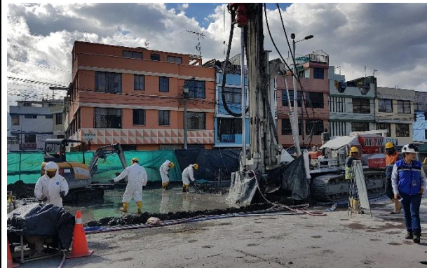
Foto 1.- 01/08/17 Trabajos de perforación e inyección
