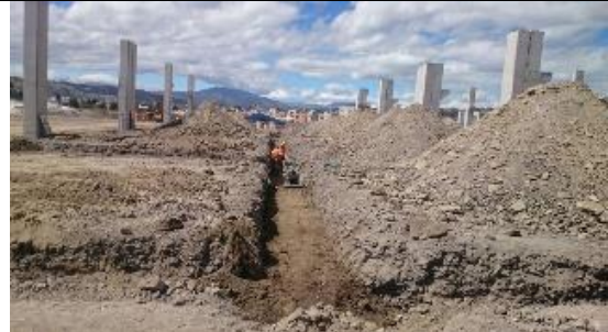
Foto 7.- Zanja de Puesta a tierra.
