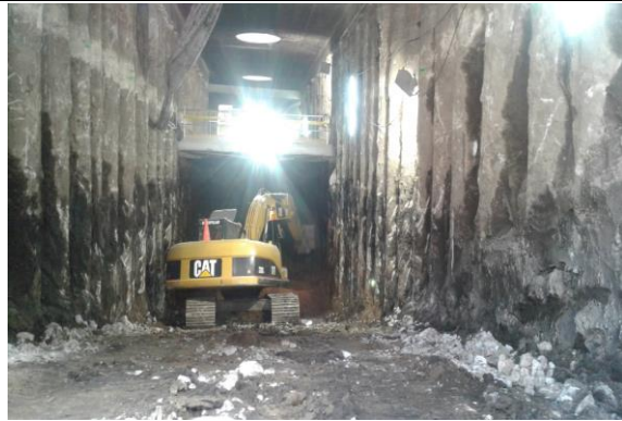
Foto 6.- Excavación bajo losa de vestíbulo a cota de losa de entreplanta.
