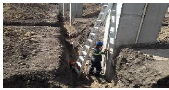
Foto 8.- Zanja de Puesta a tierra.
