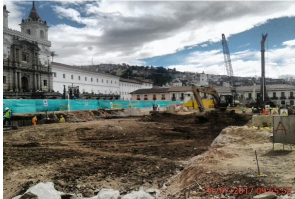
Foto 5.- 31/07/2017. Excavación en suelo hasta nivel de losa de cubierta
