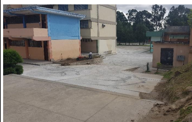
Foto 3.- 09/08/17 - Trabajos de readequación terminados.
