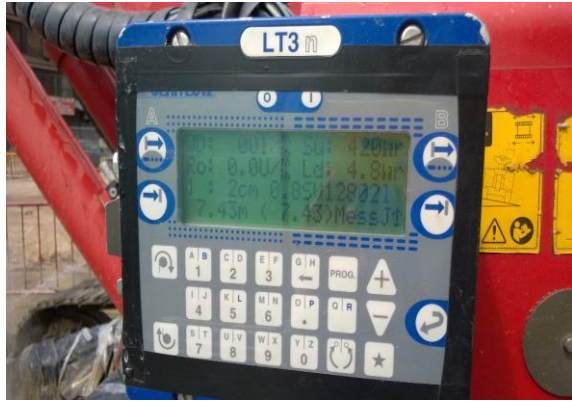
Foto 2.- 11/08/2017. Corralito Sur para la Estación La Magdalena: Inyección de taladro M310.
