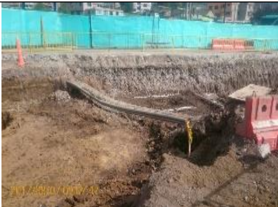
Foto 5.- Excavación para muros guía.
