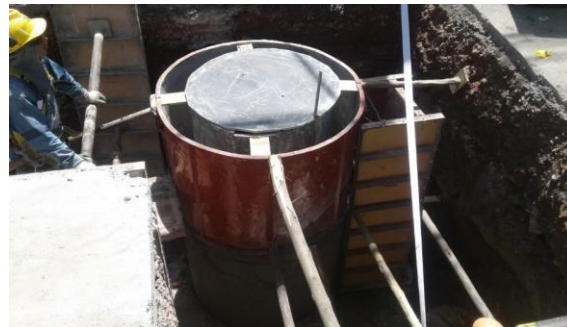
Foto #2: 02/08/2017. Ejecución de pozo de salto de alcantarillado, estación El Recreo.
