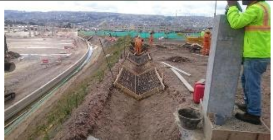
Foto 6.- Cuneta de Coronación.
