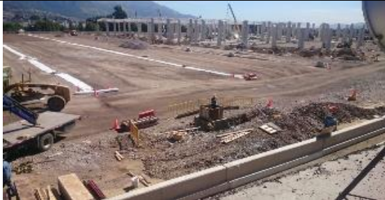
Foto 5.- Vista general de playa de vías con sub-balasto terminado.
