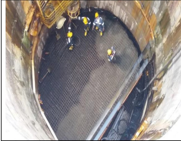
Foto 3.- Fundición de solera de fondo
