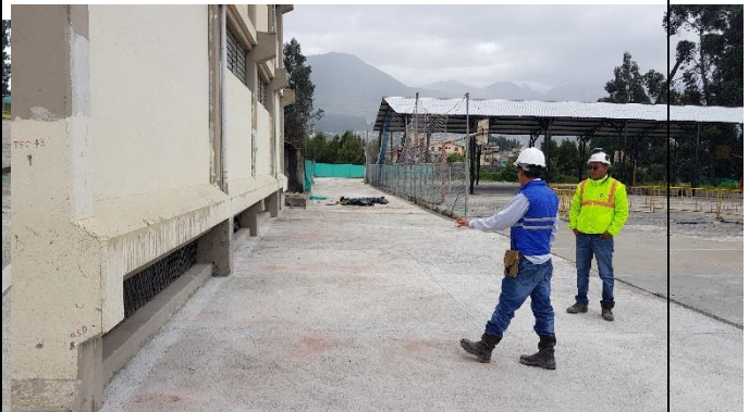
Foto 2.- 08/08/17 – Verificación de pendientes en los hormigonados de la vereda.
