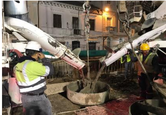
Foto 5.- 30/07/2017. Hormigonado en conjunto de pantallas #C-6 y C-7 de corralito norte.
