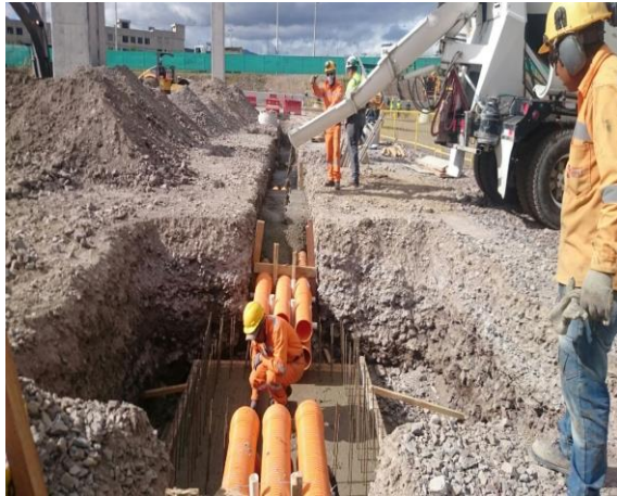
FOTO 3: Hormigonado de canalización en vía de pruebas.
