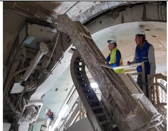
Foto 6.- 27/07/17 Inspección de los cepillos del escudo de cola de la EPB1022
