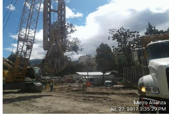
Foto 4.- 27/07/2017. Excavación de Pantalla #8.
