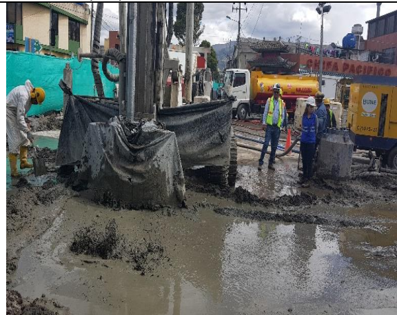
Foto 4.- 12/07/17 – Verificación de parámetros de perforación e inyección.
