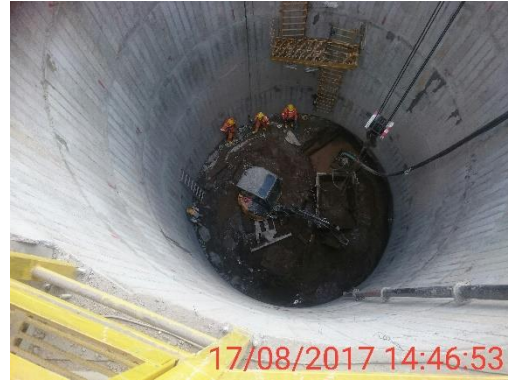
Foto 2.- Ejecución de anillo de pozo.
