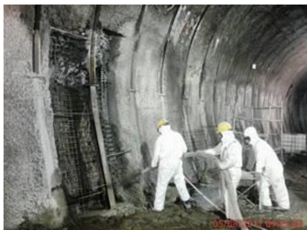
Foto 1.- 05/08/2017. Excavación a nivel de destroza, colocación de malla electrosoldada, cerchas y hormigón lanzado
