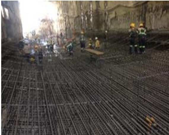
Foto 3.- Armado estructural de contrabóveda Fase 5. (Armadura superior).
