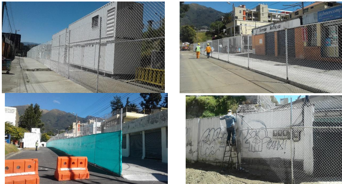
Colocación de malla galvanizada para el cierre del campamento.
