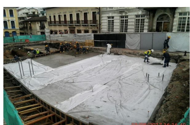
Foto 10.- 19/08/2017. Hormigonado de vigas y losa inclinada.
