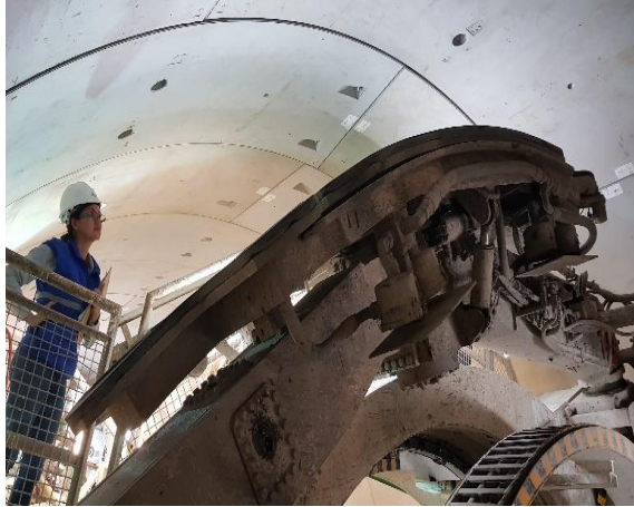
Foto 3.- 05/08/17- Inspección a la instalación de dovelas, mediante el erector.
