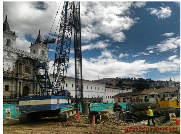
Foto 2.- 26/07/2017. Izaje y colocación de armadura de pilote.
