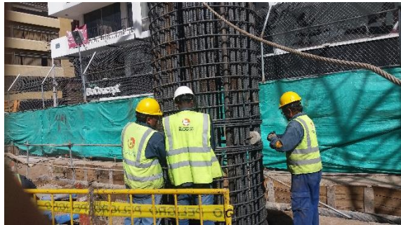
Foto 3.- Colocación de separadores en pilote #123 tipo P-4 con tubería de auscultación.
