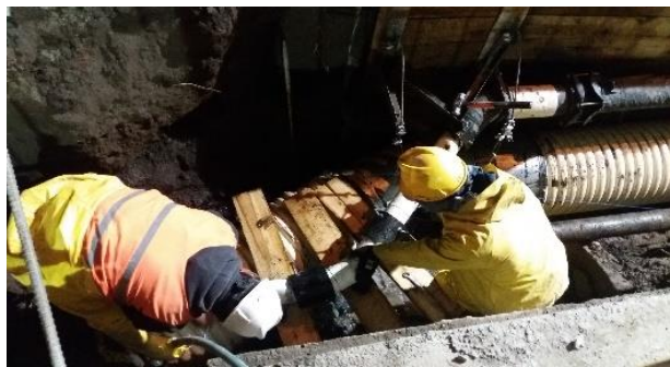
Foto #1: 30/06/2017. Interconexión de tuberías de agua potable, fase 1, estación La Pradera.
