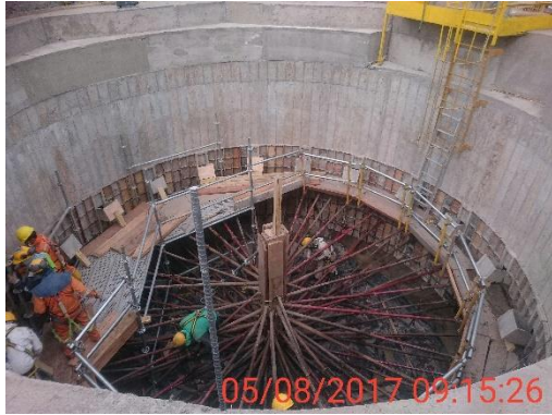
Foto 1.- Ejecución de anillo de pozo.
