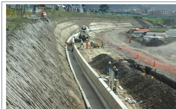
FOTO 1: Excavación para colocación de tuberías para señalización en vía de pruebas.
