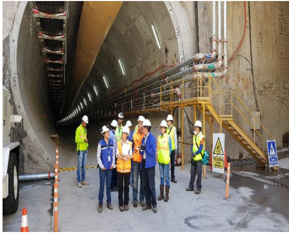
Foto 1.- 01/08/2017. Inspección de campo a las obras por parte del BID.
