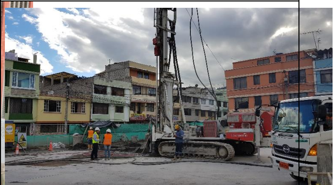
Foto 4.- 28/07/17 Trabajos de Jet Grouting.
