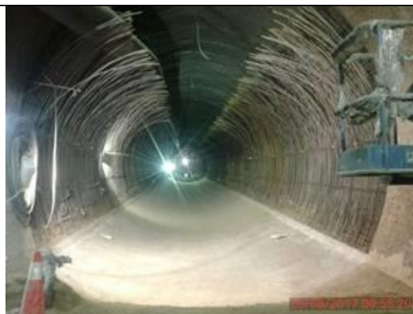
Foto 4.- 20/08/2017. Vista del hormigón de revestimiento en contra bóveda hacia el lado del Intercambiador 24 de Mayo.
