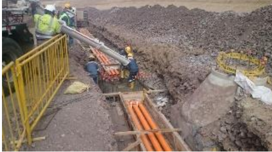
Foto 3.- Zanja de enclavamiento y señalización.
