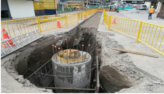
Foto 1.- Construcción de Pozo para aguas servidas K33 tipo B1.
