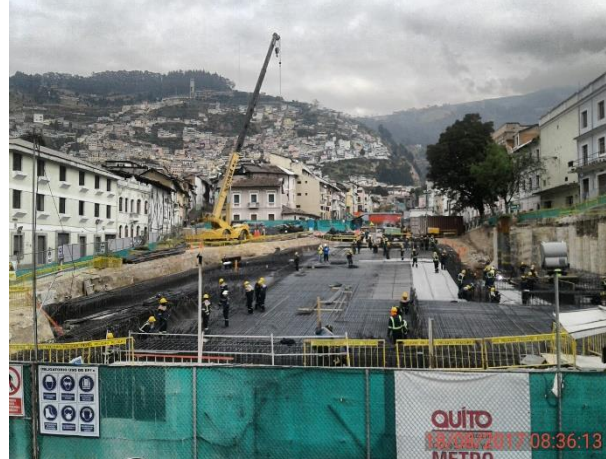
Foto 4.- 18/08/2017. Vista de la estación durante el armado de acero de losa de cubierta.
