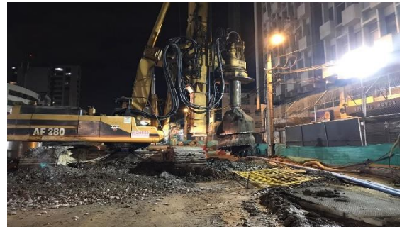
Foto 4.- Perforaciones para pilotes de estación. Maquina AF280. Pilote #56.
