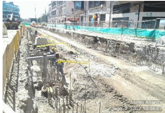
Foto 6.- 02/08/2017. Descabezado de pilotes en Av. Gran Colombia
