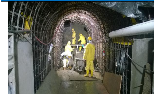
Foto #1: 05/08/2017. Ejecución de galería desde el pozo PZ1A hacia aguas arriba.
