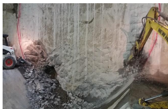
Foto 3: Derrocamiento en pantallas de acceso para eliminar el acero de pantalla que incide la trayectoria del TBM.
