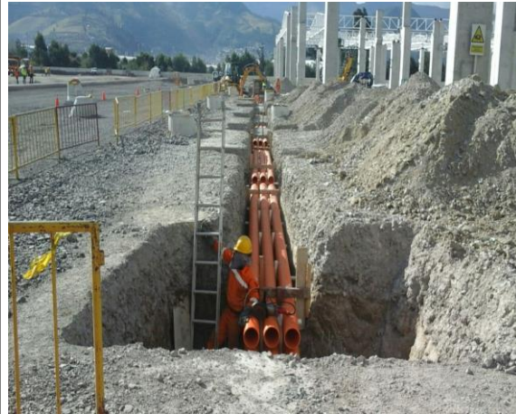
FOTO 4: Colocación de batería de 6 tubos de 110 mm. desde vía 1 hasta vía 24.
