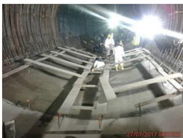
Foto 3.- 27/07/2017. Hormigón de revestimiento en contra bóveda hacia el lado del Intercambiador 24 de Mayo.
