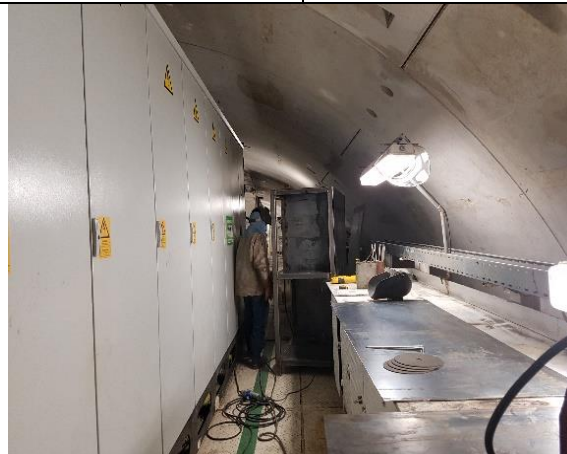
Foto 3.- 10/08/17- Limpieza de equipos.
