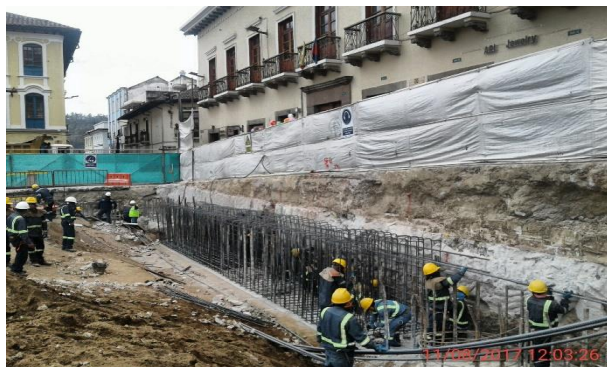
Foto 7.- 11/08/2017. Armado de acero de refuerzo de vigas, fase 5
