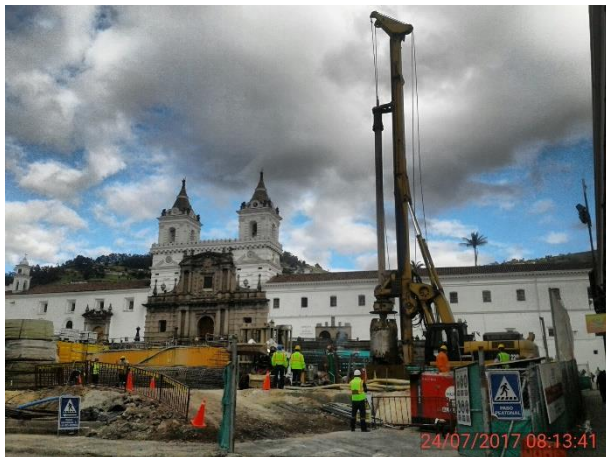
Foto 1.- 24/07/2017. Excavación de pilote.
