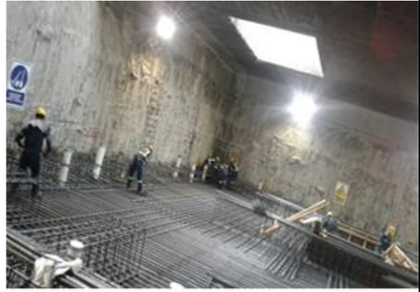
Foto 2.- Armado estructural de losa de vestíbulo fase 2.
