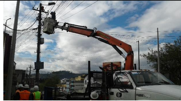
Foto #1: 29/08/2017. Desvío de redes eléctricas, estación Universidad Central.
