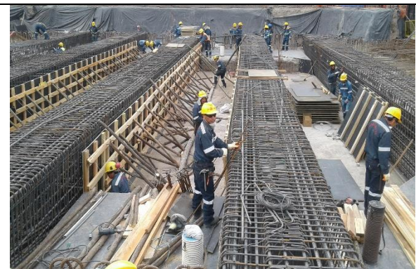
Foto 3.- Encofrado de Vigas
