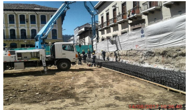
Foto 8.- 14/08/2017. Vaciado de hormigón en vigas, fase 5.
