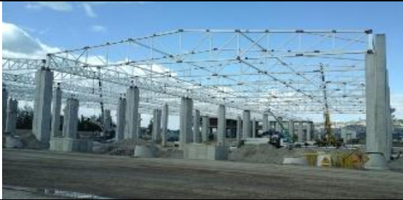
Foto 1.- Colocación de estructura metálica
