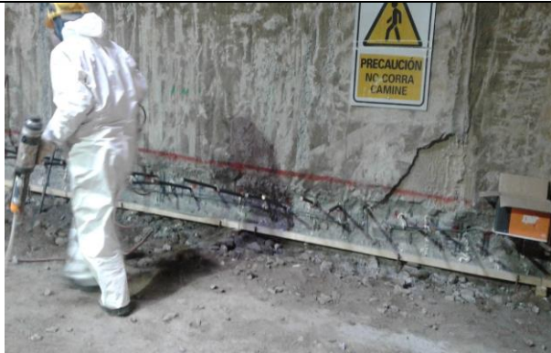
Foto 3.- Colocación de anclajes para el armado estructural de la losa.
