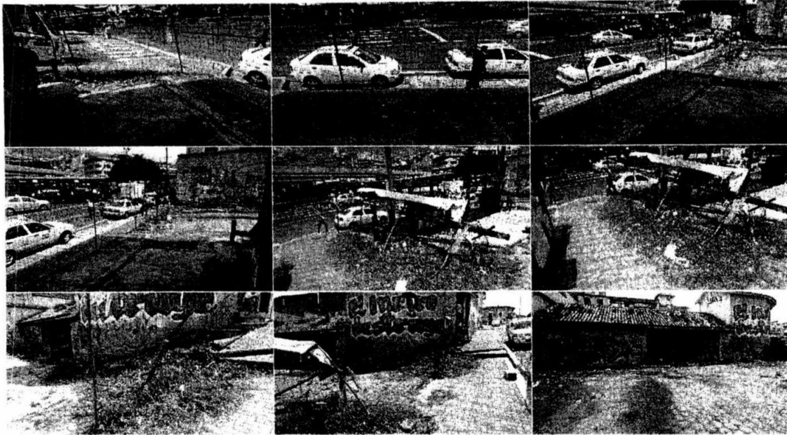
Vista del estado actual del inmueble Registrado en el Inventario de Áreas Históricas
