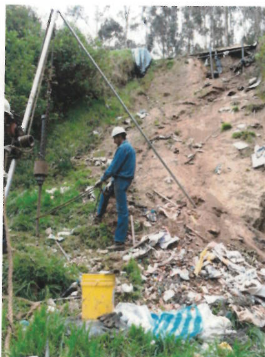
Fotografía 2: Perforación SPT No.1 al pie del talud
