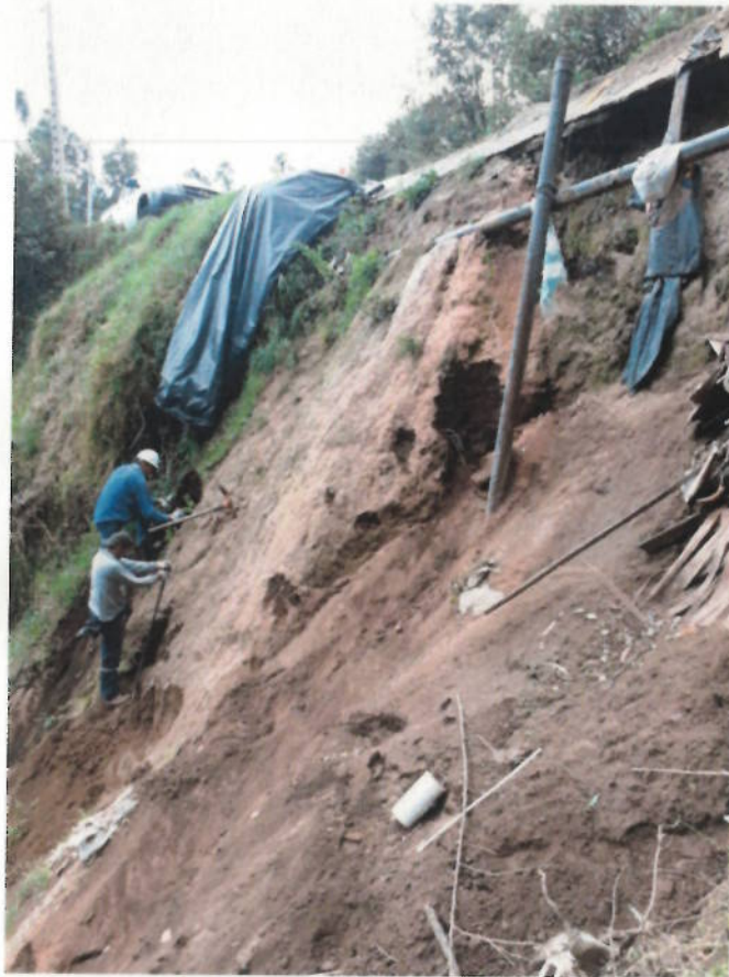
Fotografía 3: Toma de muestra inalterada a 6.50 m del nivel de la vía.
