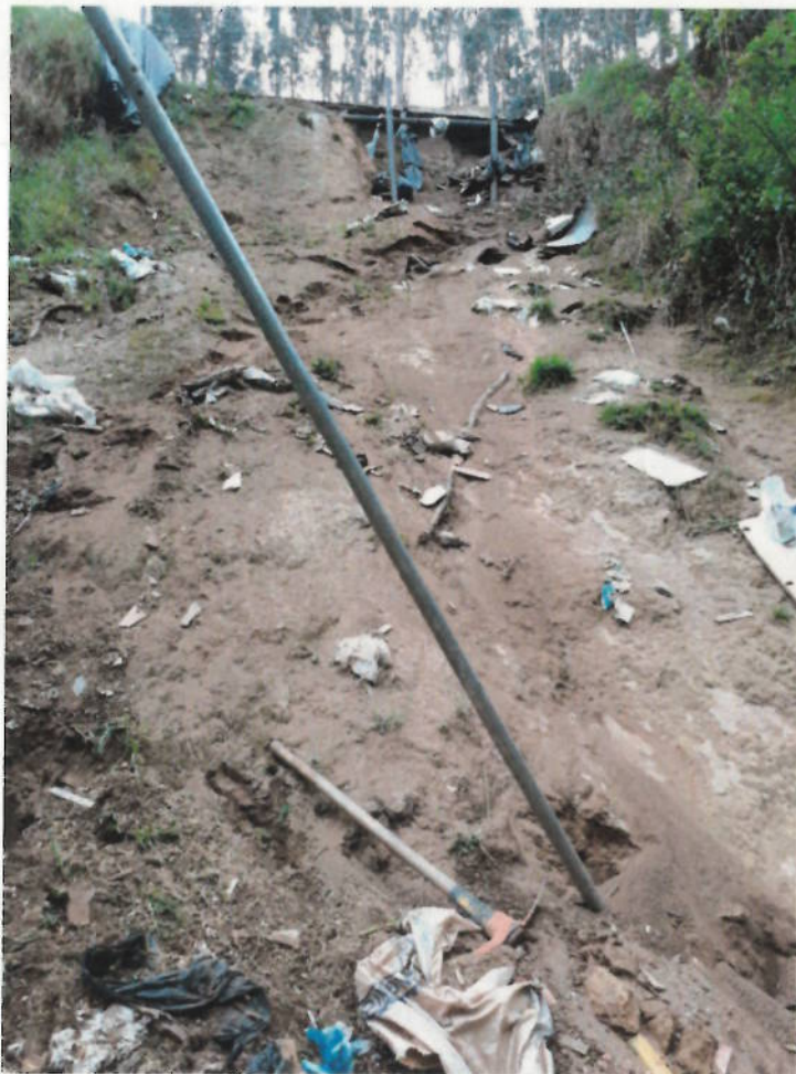
Fotografía No.1 Vista general "Talud Vía Nono"
