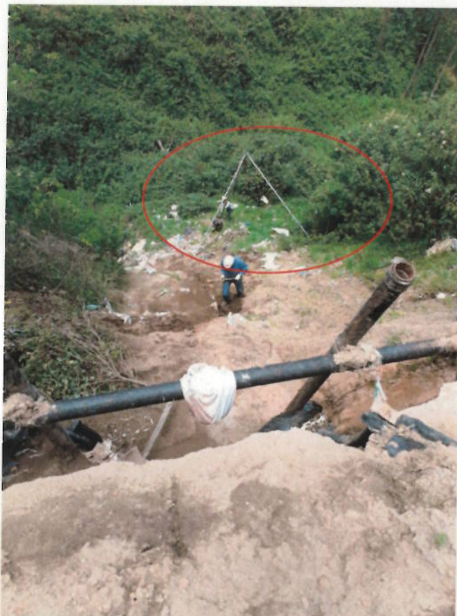
Fotografía 1: Ubicación de la perforación SPT al pie del talud
