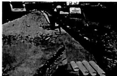
d) Canalización por tierra acometida para medio voltaje
