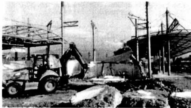
d) Canalización por tierra acometida para medio voltaje
