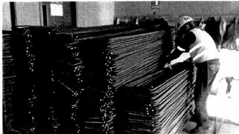
n) Armado y figurado de pedestales.
