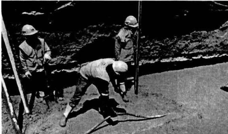
g) Fundición de replantillo en plintos.
