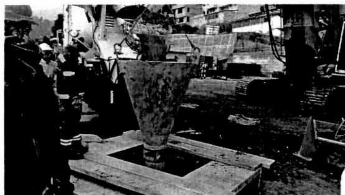
i) Fundición de 33 pilas prebarrenadas.
