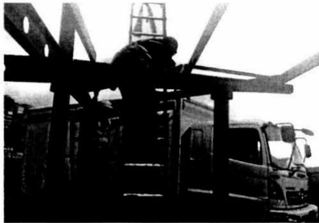
b) Desmontaje de estructura metálica existente.
