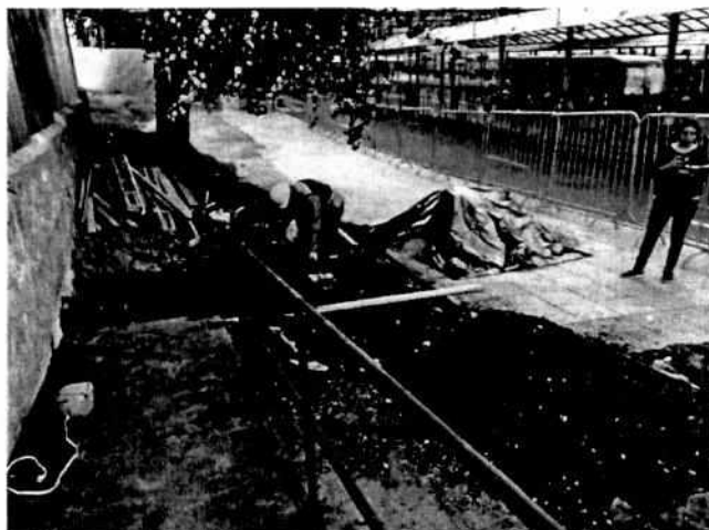
d) Replanteo y nivelación de estación, colocación de puntos para implantación de la estación.
