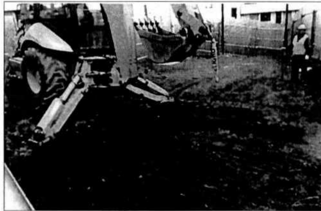
b) Derrocamiento de estructuras existentes Estación Colinas del Norte.
