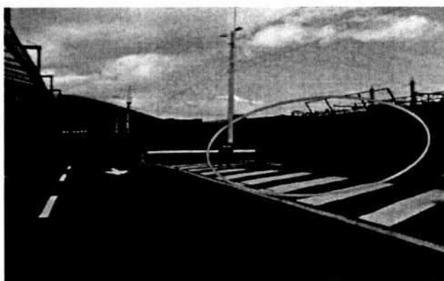
c) Desbroce de terreno para acceso provisional área de 17.0 m 2 .
