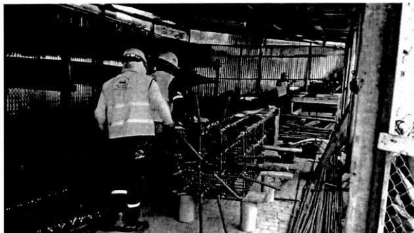
n) Armado y figurado de pedestales.
