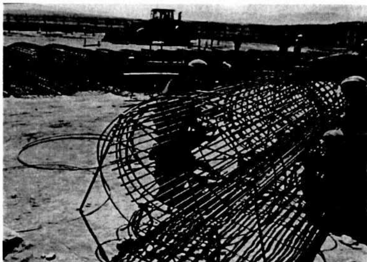
g) Figurado y Armado de acero de refuerzo de pilas.
