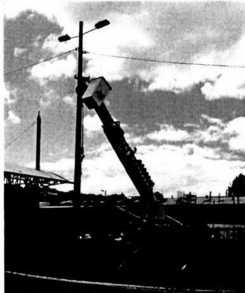
b) Desmontaje de Estructura metálica.
