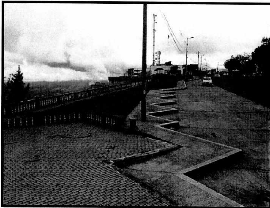
Foto 04. Mirador de las antenas
