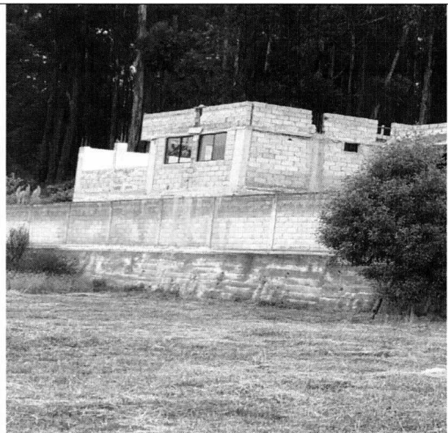
Imagen N°3: Construcción N° 1 / Adosado a predio colindante este
