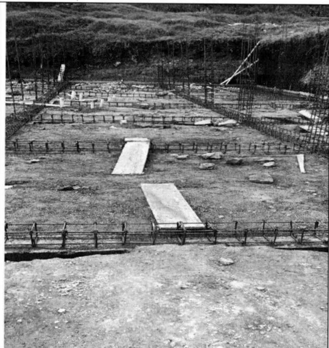
Imagen N°10: Vista Exterior / Construcción N° 6 / Construida la Cimentación
