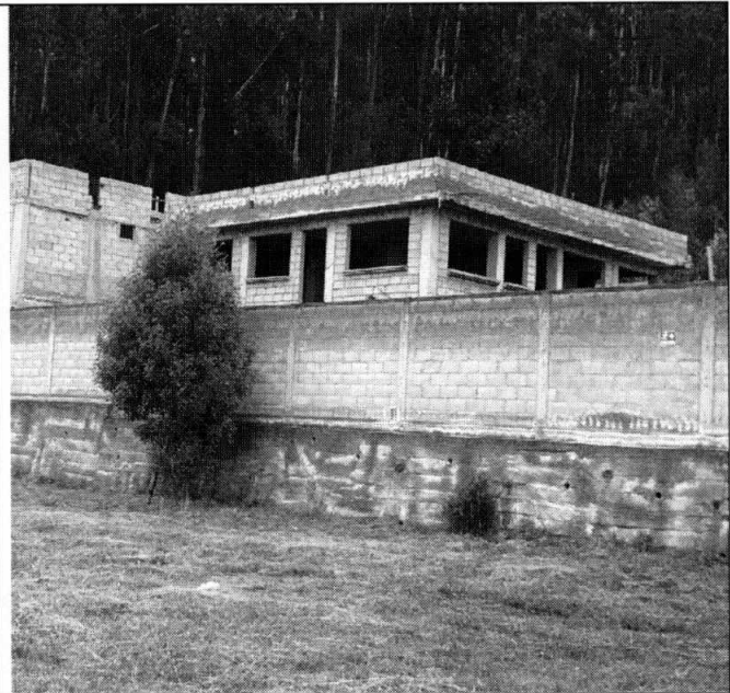
Imagen N°5: Vista Exterior / Construcción N° 2 / Fachada Este
