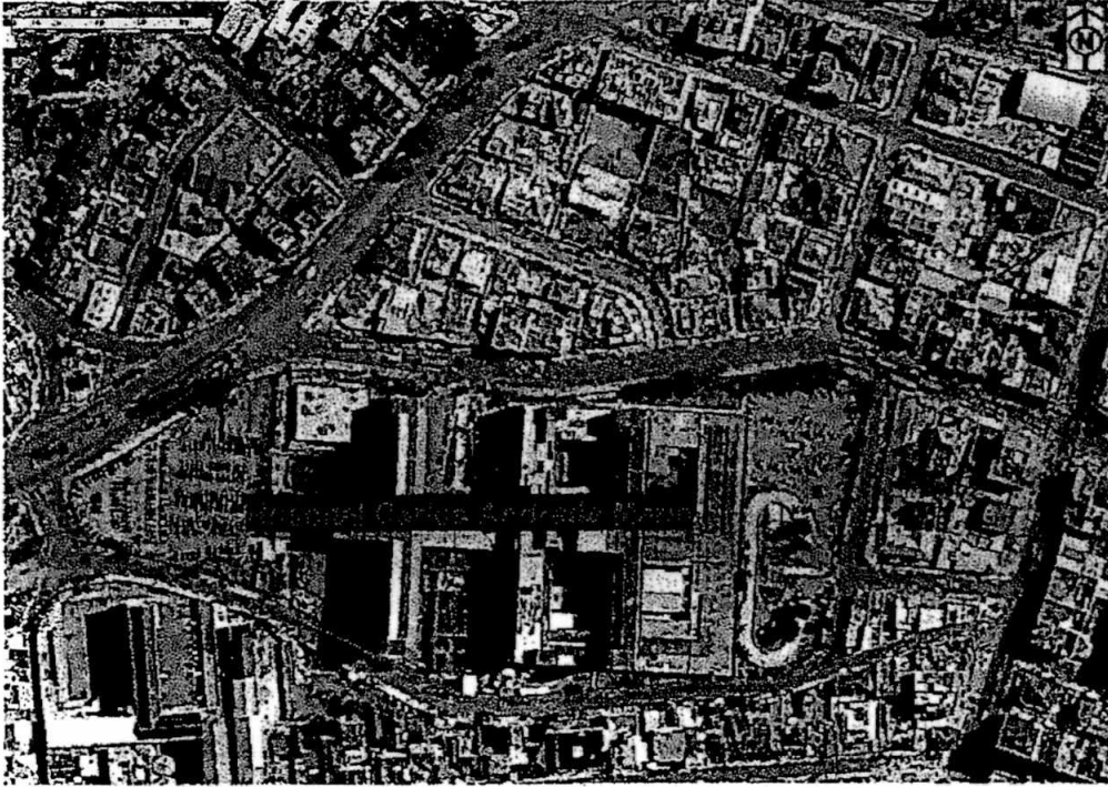
Fotografía No. 1 Vista aérea del Equipamiento Hospitalario HCAM
