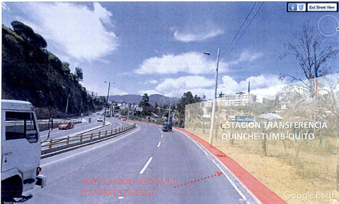
IMAGEN 3 – ACERA EXISTENTE Y ESTACION DE TRANSFERENCIA (DIRECCION ESTE):
