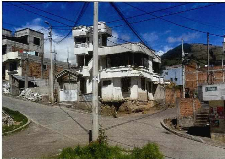
Foto 2 Calle Ulquñan e intersección con la calle S47D
