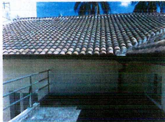
Imagen 4 Estado actual de las cubiertas
