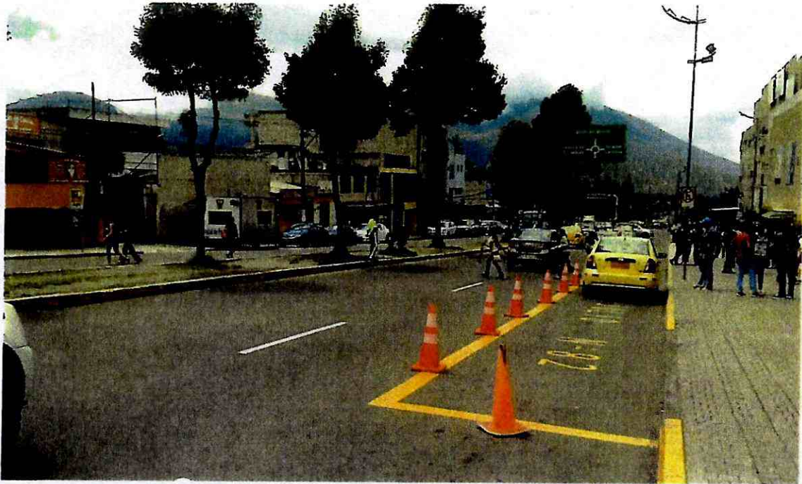
Ilustración 2 Parterre deteriorados por el cruce de peatones
