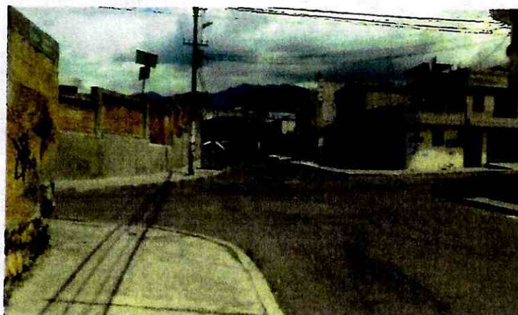
Ilustración 1 Intersección conflictiva que necesita señalización horizontal y vertical
