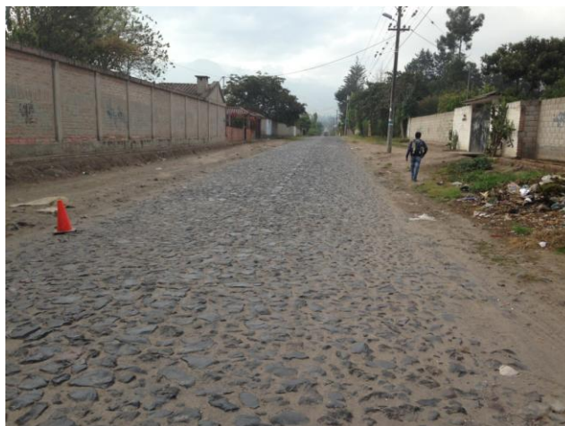
Vista empedrado calzada Calle Luis Pallares
