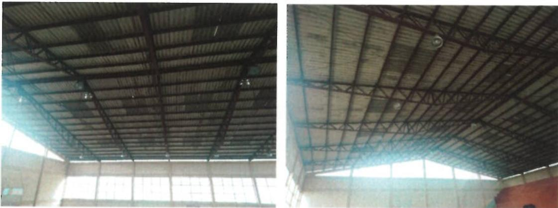
Las planchas actualmente instaladas en la cubierta presentan roturas y huecos por donde está ingresando agua a la parte interior del coliseo.
