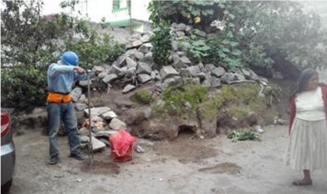
Pilona 07. Pozo a cielo abierto PCA-P07 y perforación.
