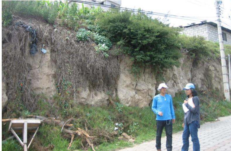
Sitio de la pizona 22. Pie del talud lado izquierdo de la calle. Los ensayos SPT y la calicata se realizaron en el sitio, al pie del talud de la vía, conformado por cangahua.
