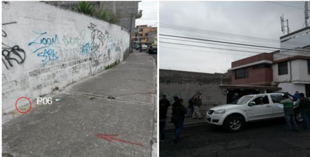
Figura 3-4 Sitio de implantación de la pylona P06
