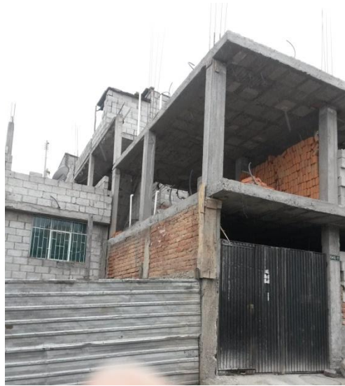
Figura 3-21 Sitio de implantación de la pylona P25
