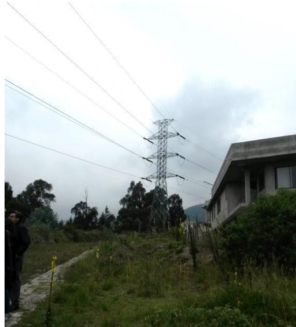
Figura 3-13 Sitio de implantación de la pylona P15
