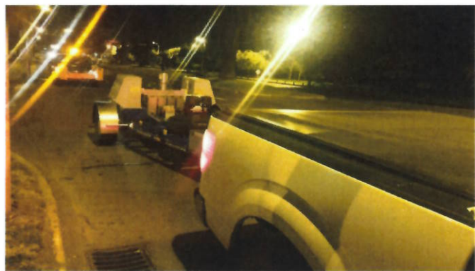
Deflectometria (HWD) pavimento flexible (Plaza Argentina Intersección Shyrís y República, Intersección Eloy Alfaro y Shyrís hasta 500 m. y Av. Diego de Almagro hasta la Av. Whympér.)
