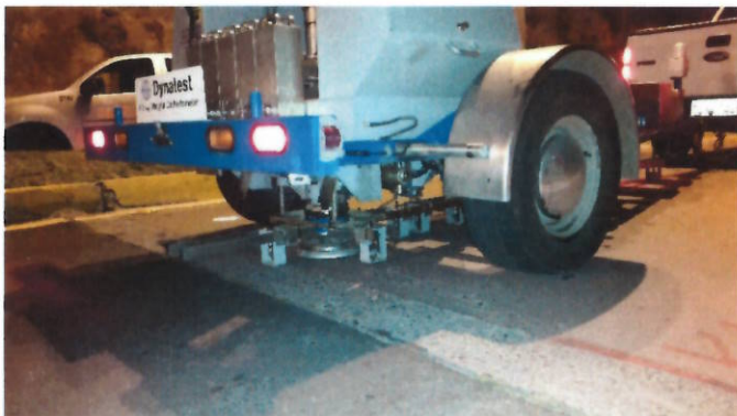
Deflectometria (HWD) pavimento rígido Túnel Guayasamín
