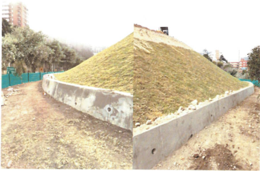
- Armado de muro interno de hormigón ciclópeo de pie de talud.
