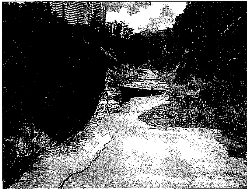
Figura 24. Deslizamiento de la vía debido a la constante erosión en la ladera inferior.
