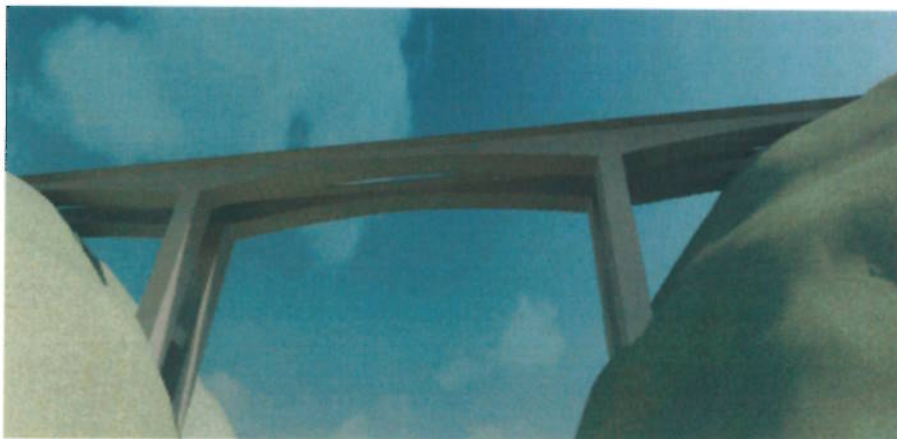
PUENTE EN VOLADOS SUCCESIVOS
