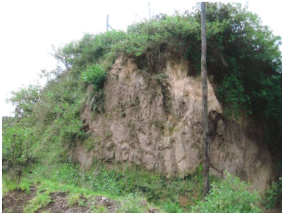
Talud de cangahuas "retrabajadas" por deslizamientos actualmente estabilizados. Km 1 Ruta Sur.
