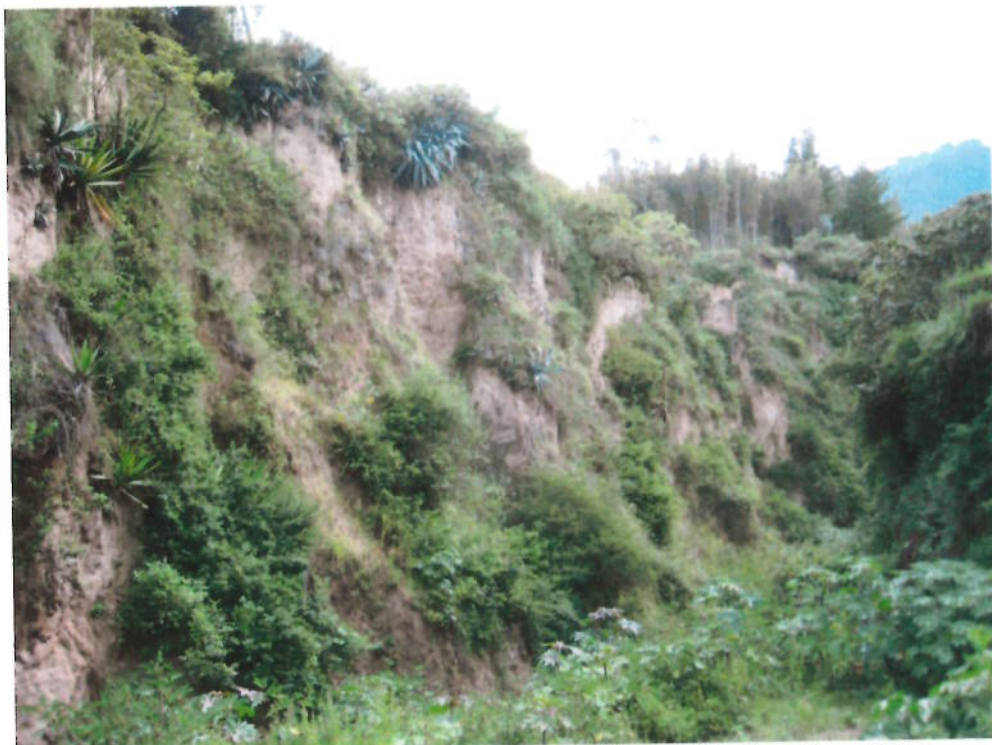
Taludes casi verticales de quebradas y quebradillas en Ruta Sur. Cangahuas.
