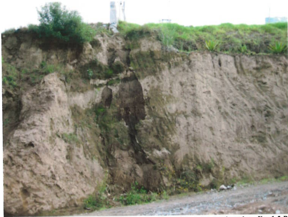
Susceptibilidad de las tobas y arenas de la Formación Cangahua a ser erosionadas. Km 1,5 Ruta Sur.
