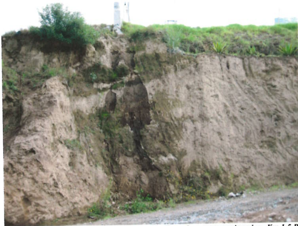
Susceptibilidad de las tobas y arenas de la Formación Cangahua a ser erosionadas. Km 1,5 Ruta Sur.
