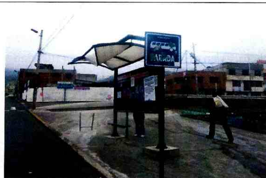
Módulo instalado en pendiente CALLE MENA 2 SECTOR: ANGAMARCA
