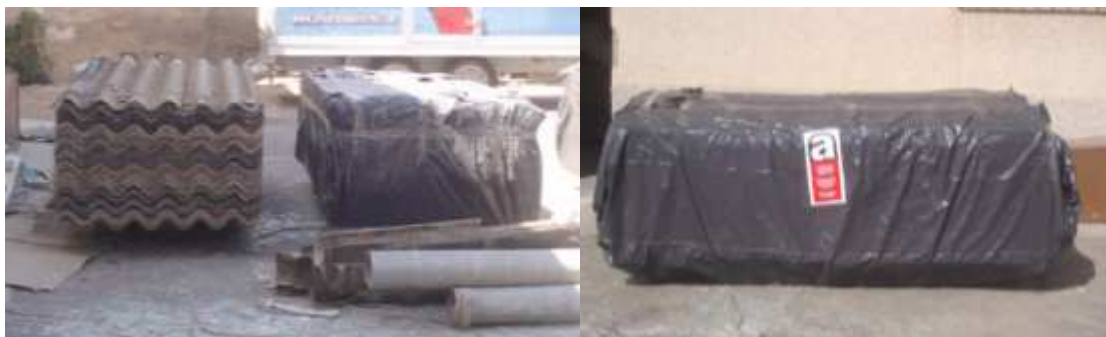
Placas embaladas y el símbolo del amianto
