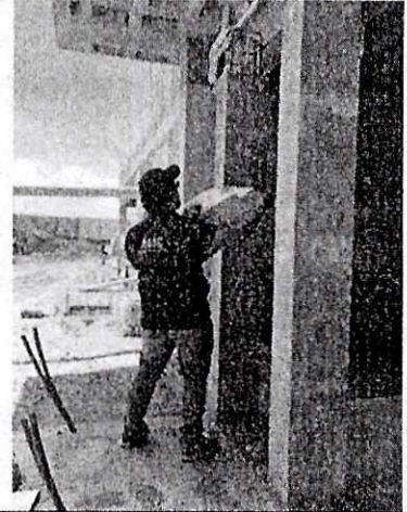
Imagen N° 2: Colocación de sello de suspensión en el acceso de parqueaderos
