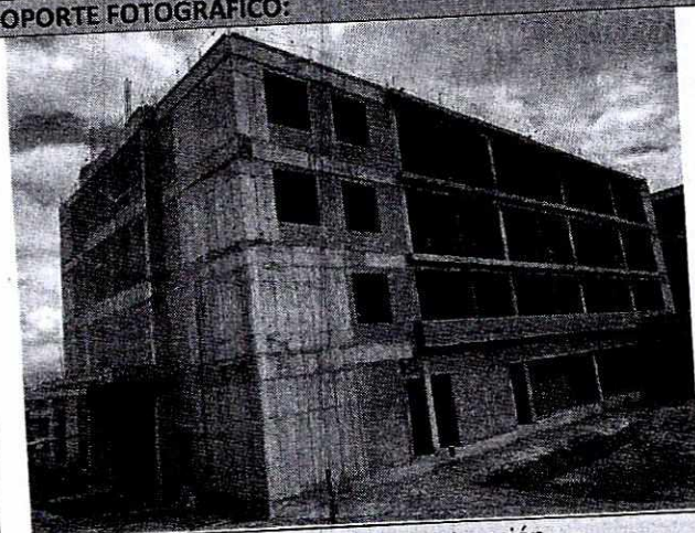
Imagen N° 1: Vista general de la construcción.
