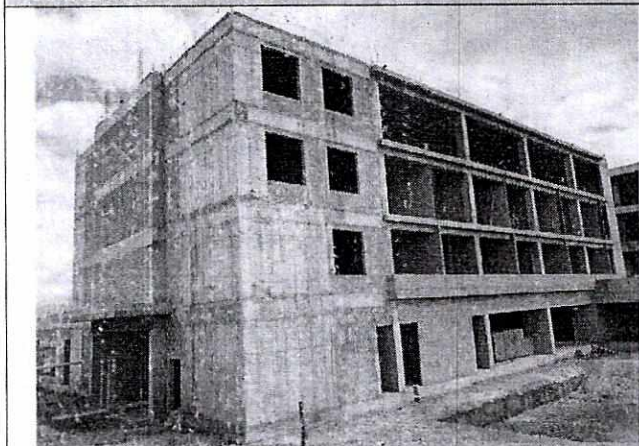
Imagen N° 1: Vista general de la construcción.
