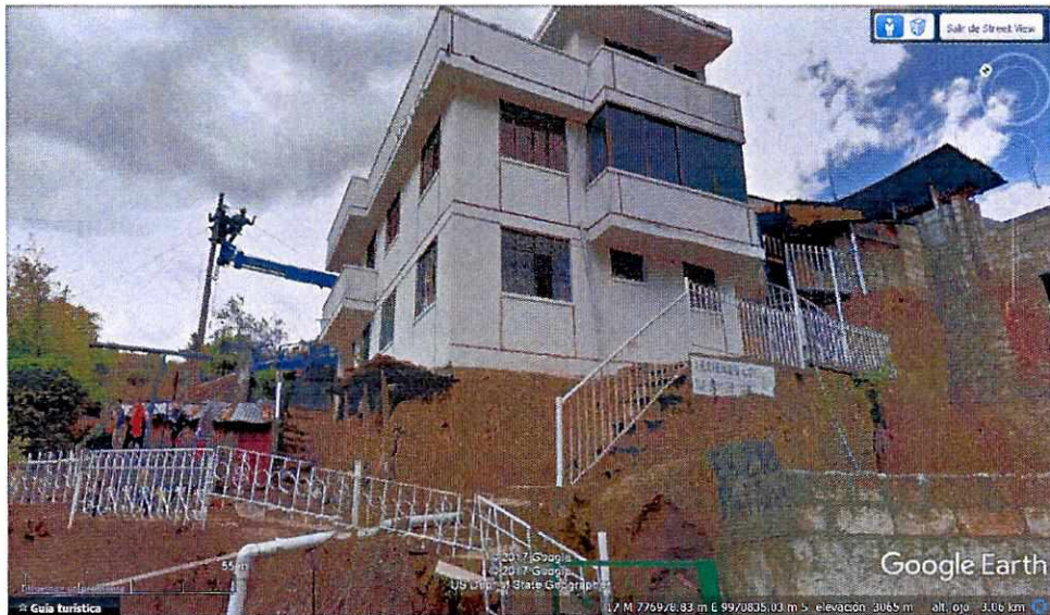
8.1.4 Cortes verticales en el terreno del Lote 7 que originó taludes vulnerables a la acción del agua lluvia
