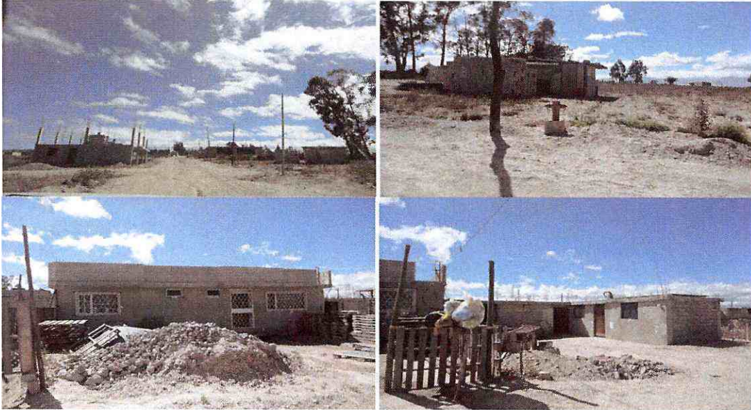
8.1.3 Corte de terreno y servicios basicos para el manejo de agua de escorrentia
