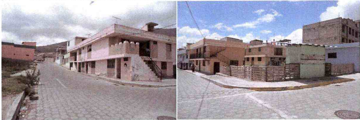
8.1.3 Corte de terreno y servicios basicos para el manejo de agua de escorrentia
