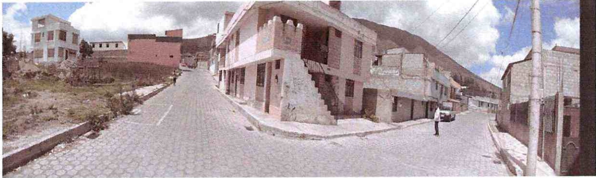
8.1.2 Materiales de las edificaciones construidas alrededor del area en estudio
