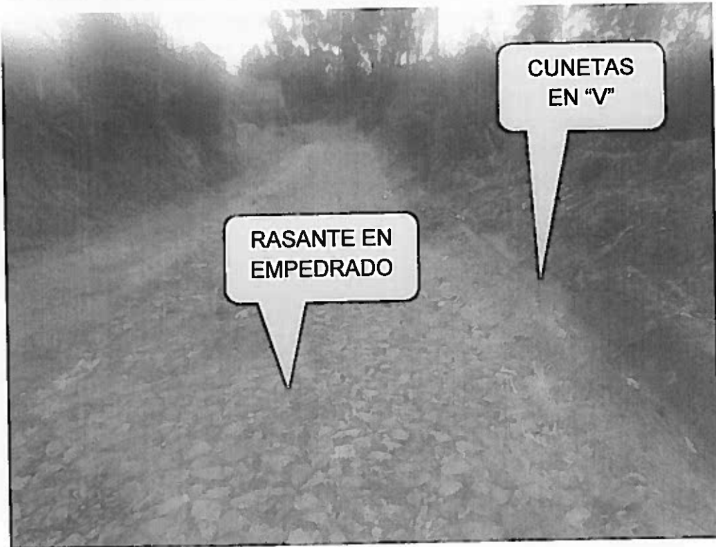
Calle empedrada Las Avestruces, con cunetas en V
