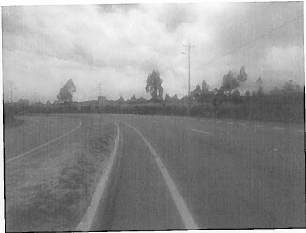
Curva de la Vía E-35 con una Señal Preventiva, ingreso a la calle Las Avestruces
