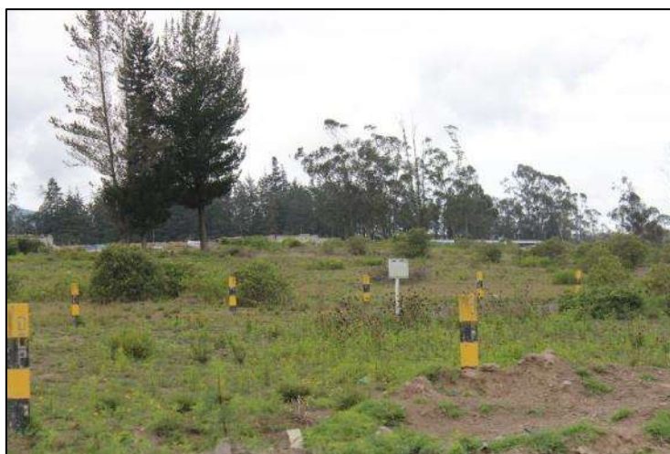
Foto N° 6.91. Oleoducto de crudos pesados
