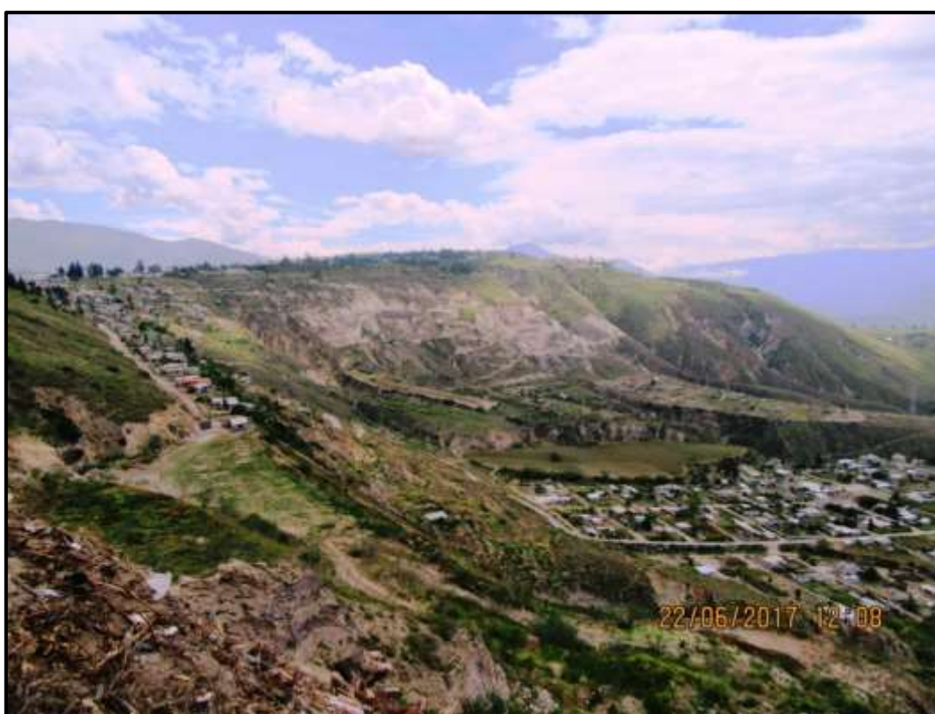
Foto N° 4.8. Parte central del talud del deslizamiento de Laderas de San Francisco, con su típica forma de “herradura”
