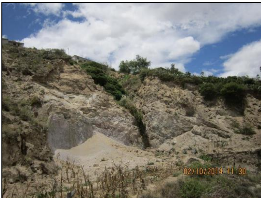
Foto N° 8.4. Colapso de talud en LSF, se ve cómo se han combinado colapsos y caídas de materiales en una de las vías de acceso al barrio
