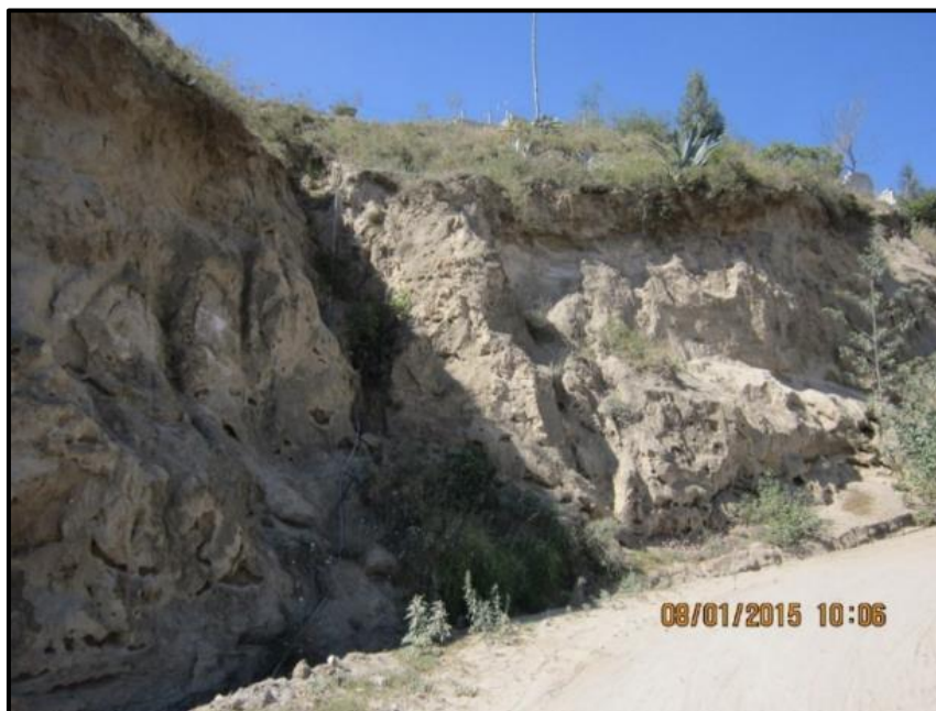
Foto N° 7.12. Formación de pequeñas cárcavas producidas por el golpe de las gotas de agua
