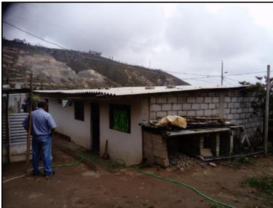
Foto N° 10.7. Estructura de mampostería semiconfinada con columnetas – Planada de San Francisco
