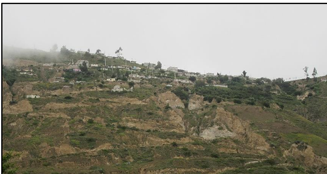
Foto N° 7.1. Barrio Laderas de San Francisco, Pedregal y Terrazas de Bellavista en zona de muy alta susceptibilidad por terrenos inestables, se notan intensos procesos erosivos
