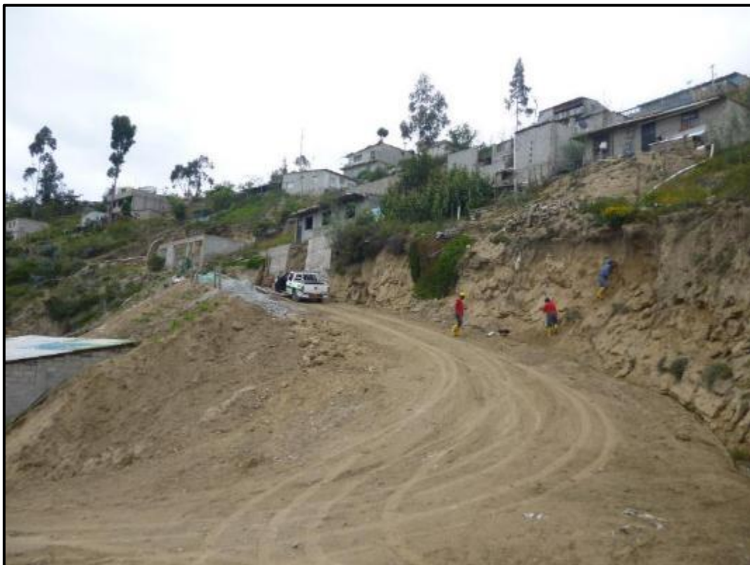
Foto N° 9.12. Distribución de las viviendas en el talud
