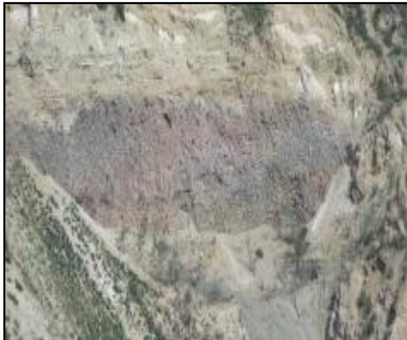
Foto N° 9.5. Depósito Avalancha de Escombros
