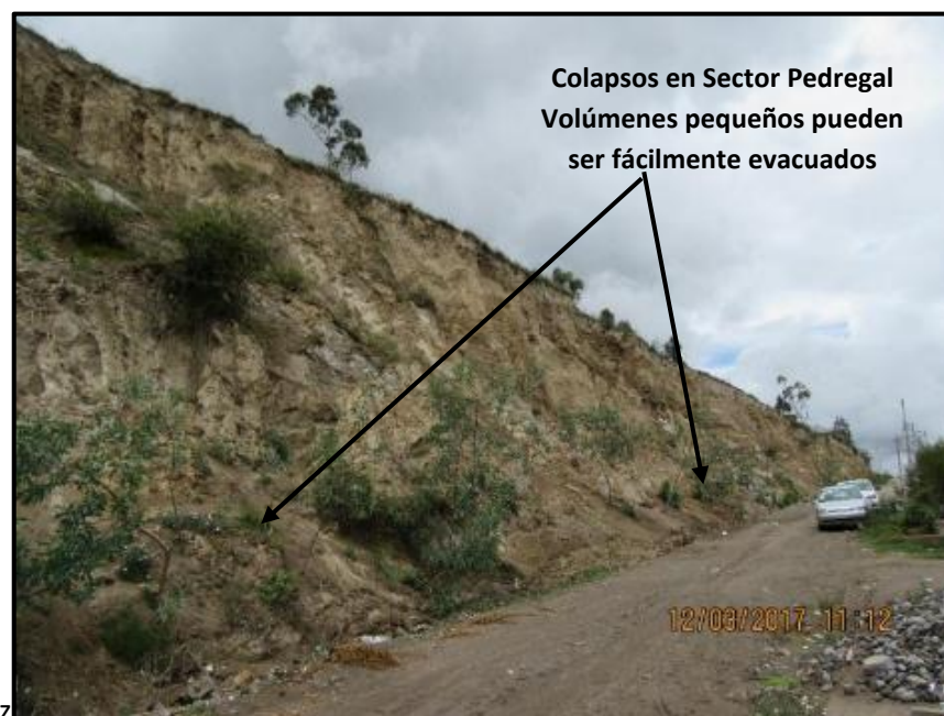
Foto Nº 11.3. Sector del Barrio Pedregal, se observan Cangahua y lapilli deleznales que pueden caer hacia el camino de acceso al barrio
