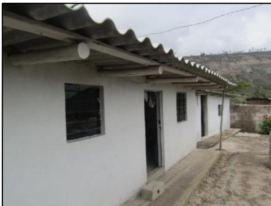
Foto N° 10.5. Estructura de mampostería simple – Planada de San Francisco
