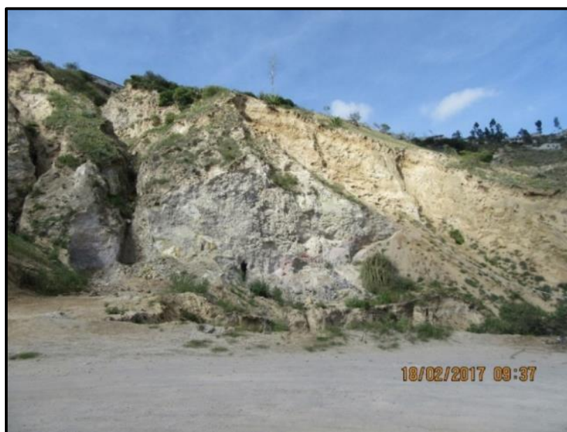
Foto N° 7.10. Muestra de laderas erosionadas fuertemente por el viento y agua
