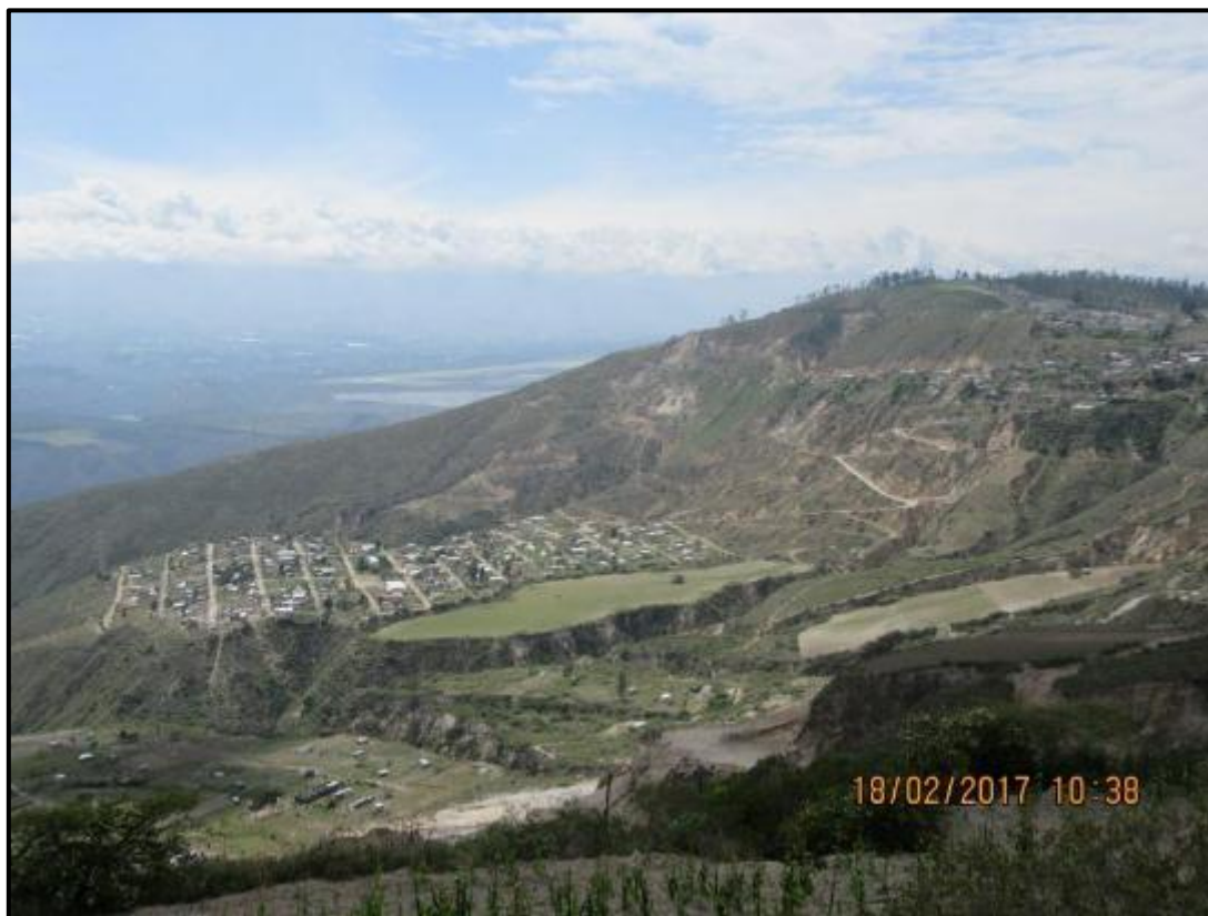
Foto Nº 9.10. Deslizamiento rotacional sucesivo de la zona
