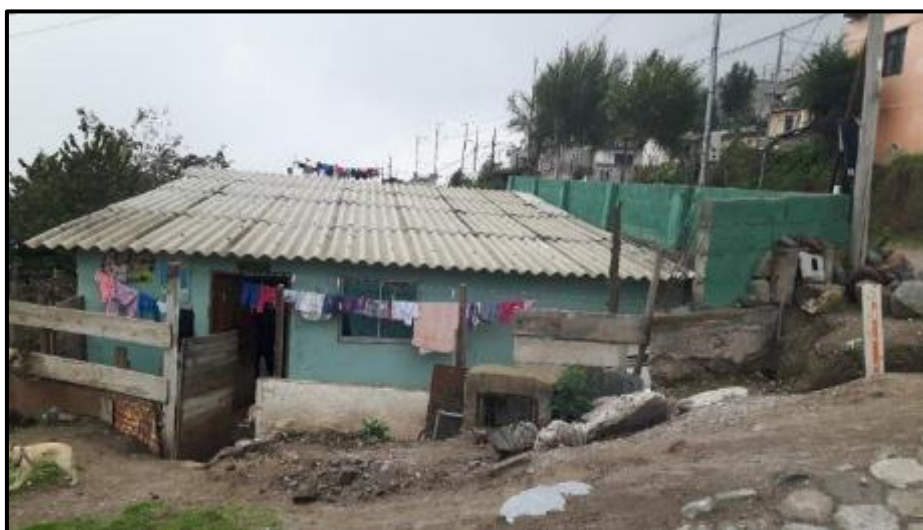
Foto N° 10. 6. Estructura de mampostería simple – Laderas de San Francisco
