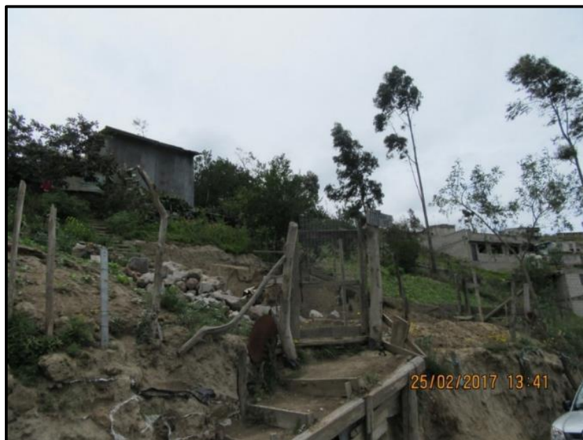
Foto N° 7.9. Huellas de escurrimiento superficial de agua lluvia
