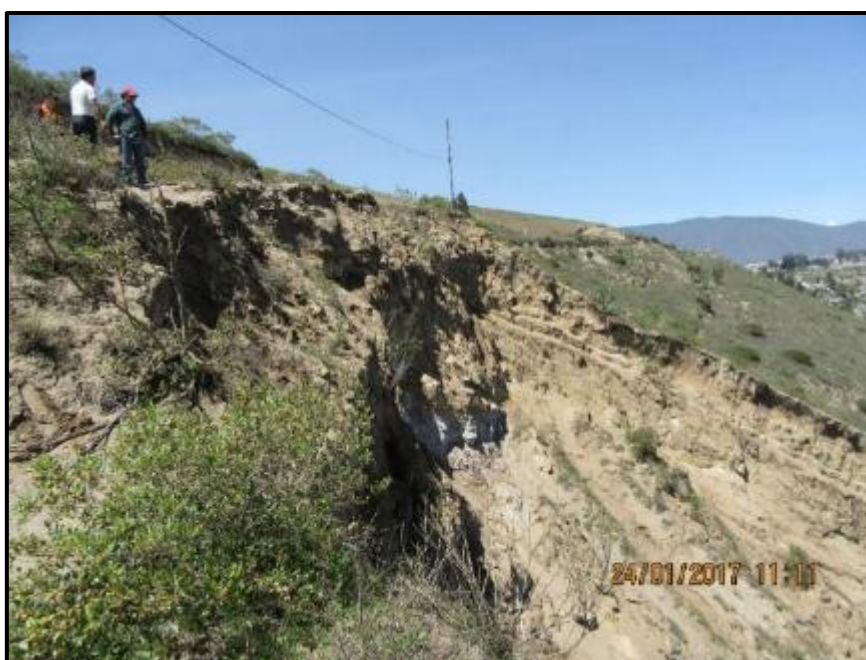
Foto N° 8.1. Caída de bloques en la el acceso a la cantera abandonada
