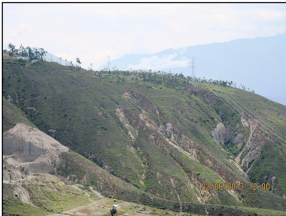
Foto N° 8.16. Inestabilidad de Terrenos en el sector del Barrio San Vicente (UTM: 788530 E / 9994238 N) se observan intensos procesos de erosión y colapsos hacia las quebradas
