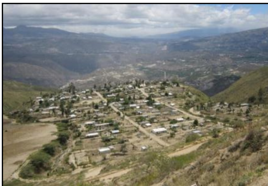
Foto N° 8.14. Planada de San Francisco, zona de amenaza baja, terrenos estables, se debe cuidar el uso del agua para evitar erosión y hundimientos.
