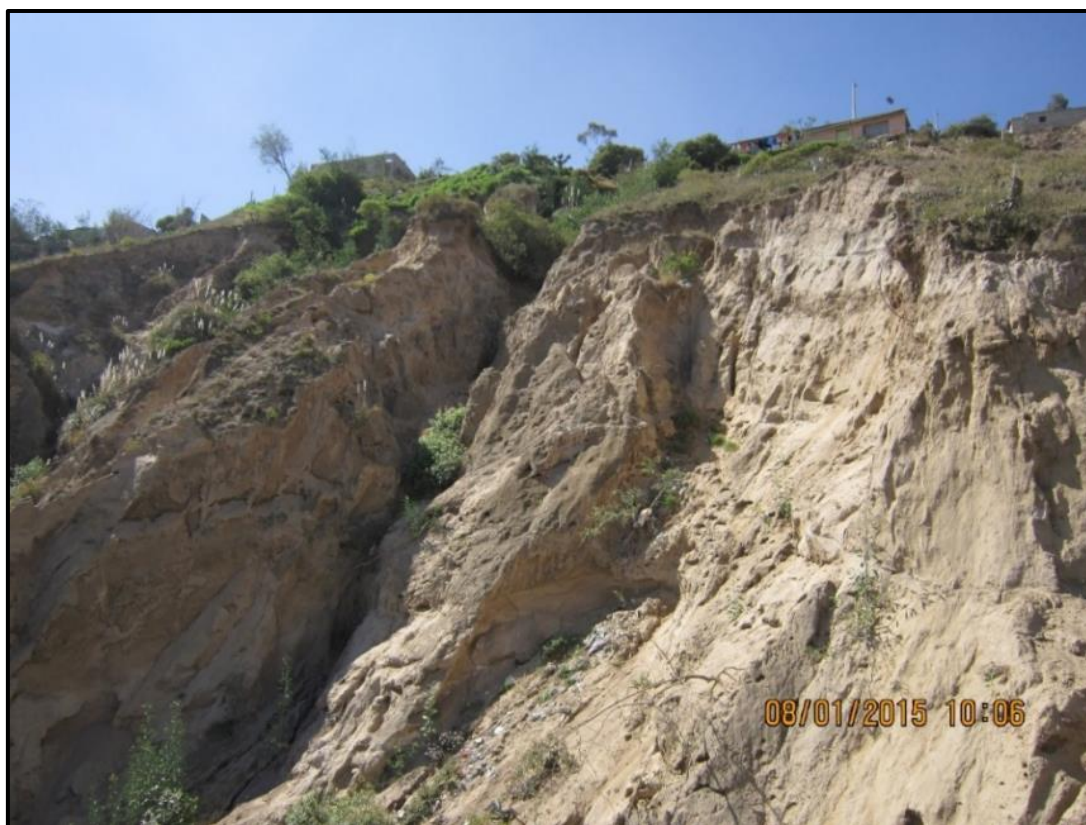
Foto Nº 7.11. Forma típica de erosión por precipitación en laderas de suelos sueltos
