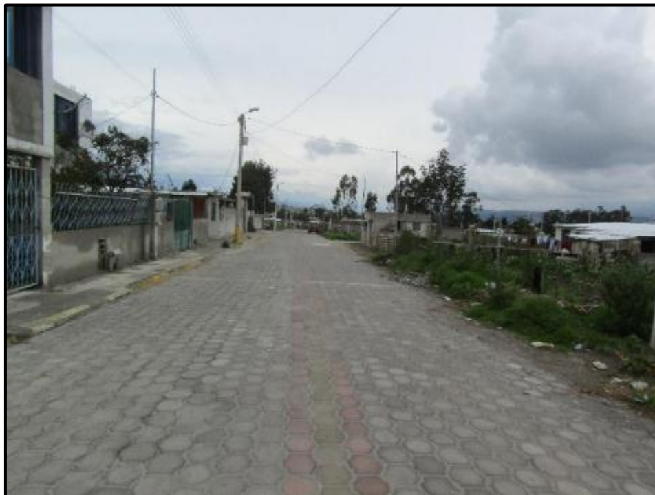
Foto N° 10.14. Vía adoquinada en el barrio Cristo Rey I, sin sistemas de drenaje
