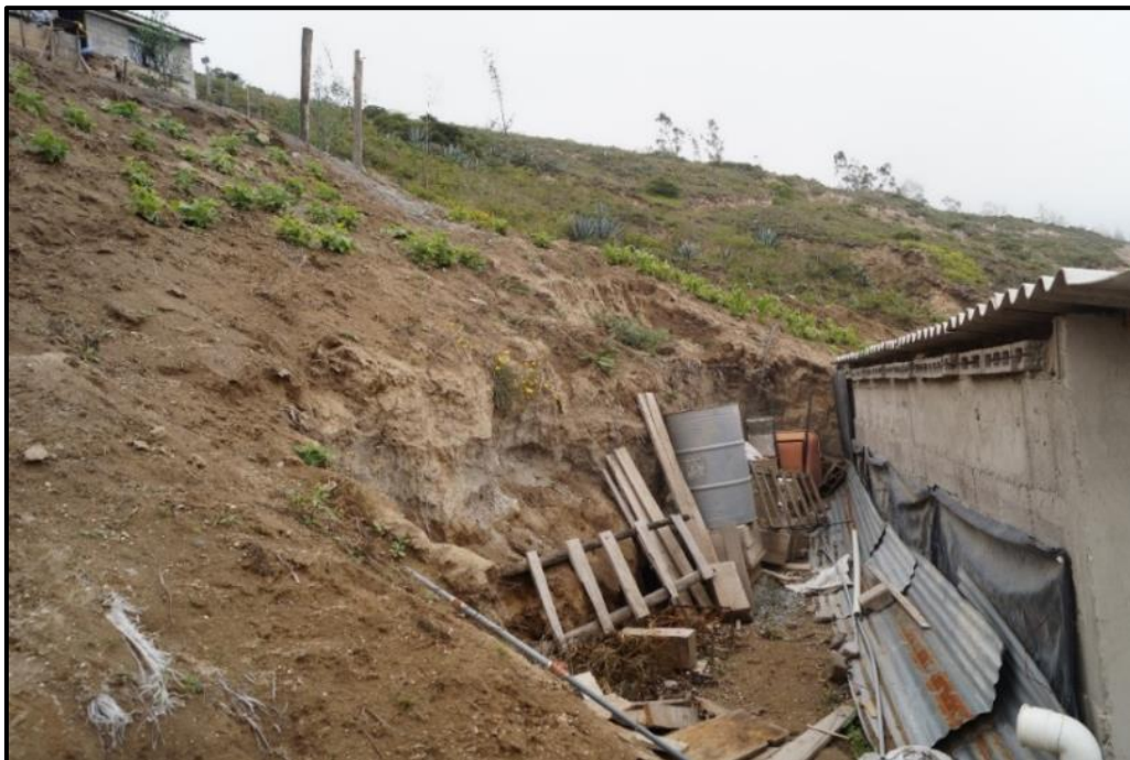
Foto N° 7.14. Formación de erosión laminar por terrazas para construcción de viviendas
