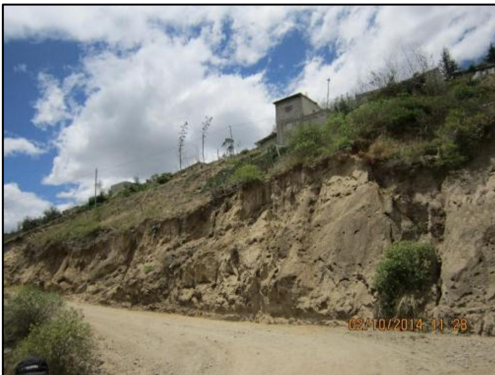
Foto N° 8.7. Erosión y colapsos en el camino de acceso a Planada de San Francisco es difícil detener los procesos y las casas están amenazadas de caer por colapsos.
