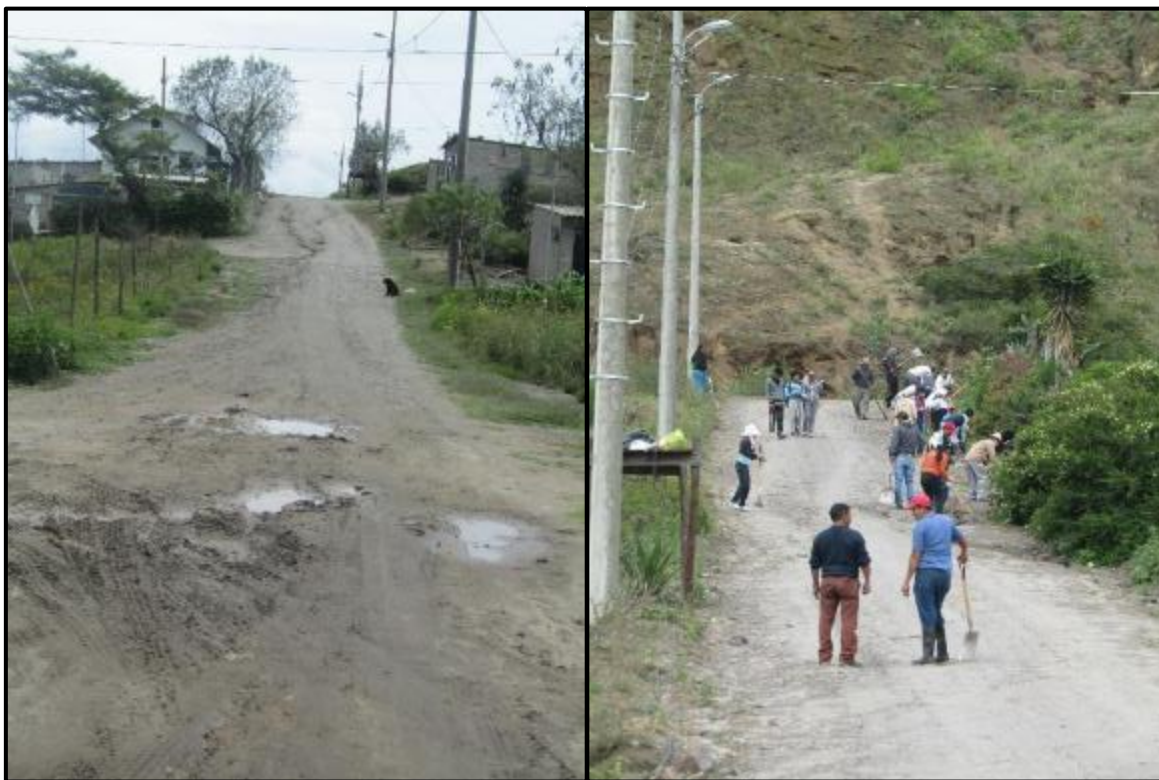
Foto Nº 10.8. Camino de tierra en Planada de San Francisco, se observan hondonadas, surcos y vegetación en la vía
