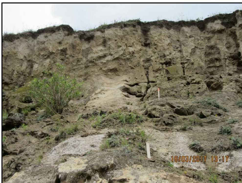
Foto N° 14.2. Sistema de monitoreo de FRM en Pedregal, con estacas con nivel y estacas de erosión para medir el avance de los terrenos inestables.
