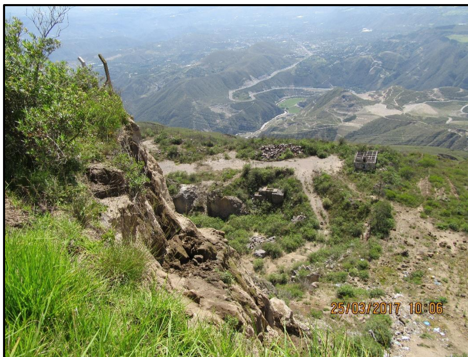
Foto N° 12.1. Cantera abandonada cerca al barrio Colinas de Bellavista, existe material de escombrera, infraestructura y desechos abandonados.
