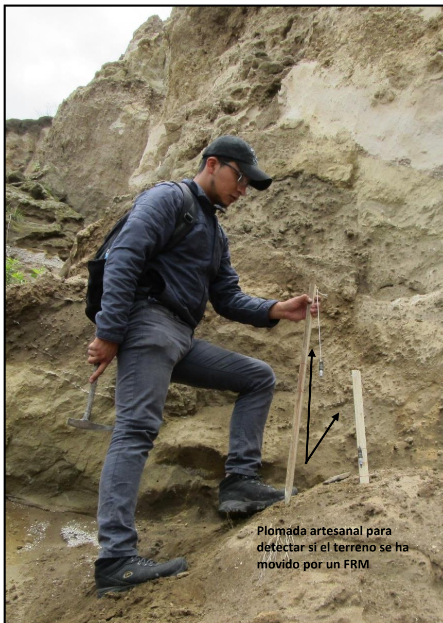
Foto N° 14.1. Estaca con nivel (plomada) artesanal, si el terreno cede, entonces se formará un ángulo mayor entre la estaca y la piola del nivel.
