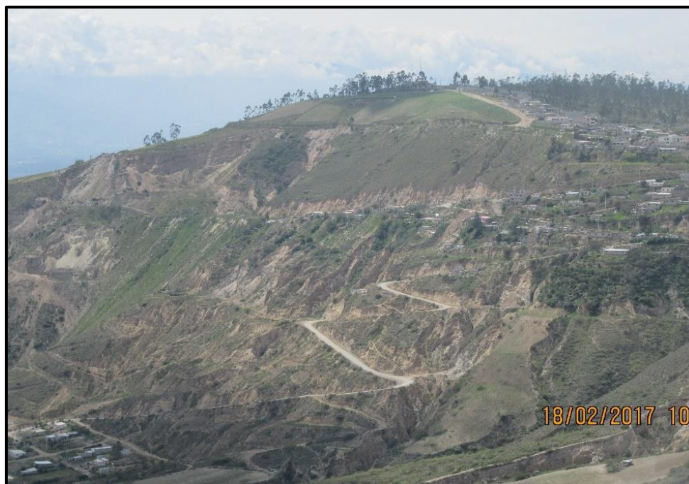
Foto N° 13.1. Acceso a Planada de San Francisco, camino sin diseño vial adecuado
