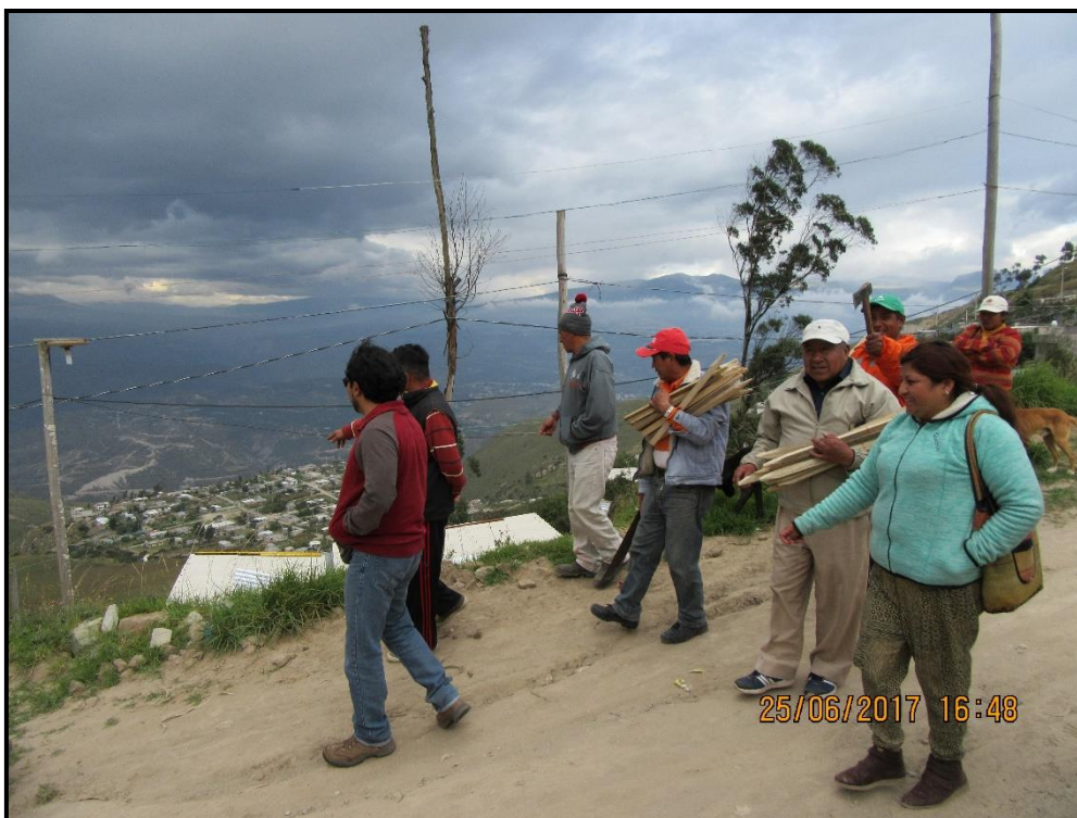
Foto N° 14.3. Sistema de monitoreo de FRM en Terrazas de Bellavista, instalación de las estacas de nivel con la participación de los vecinos del sector.
