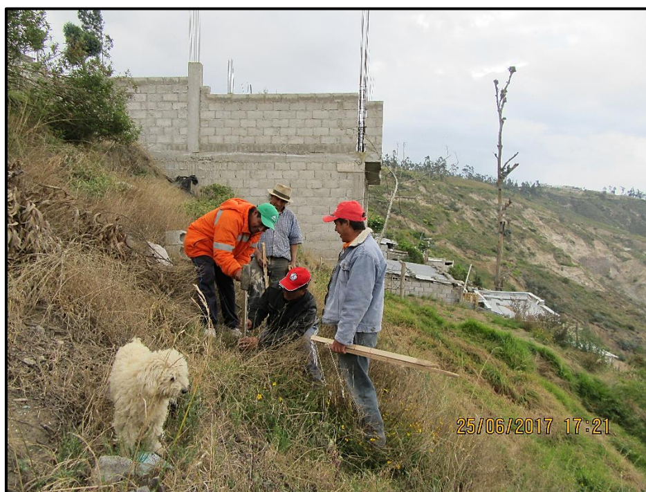
Foto N° 14.7. Vecinos del Barrio Terrazas de Bellavista clavando las estacas de nivel en el sistema de monitoreo del SAT de la misma localidad.
