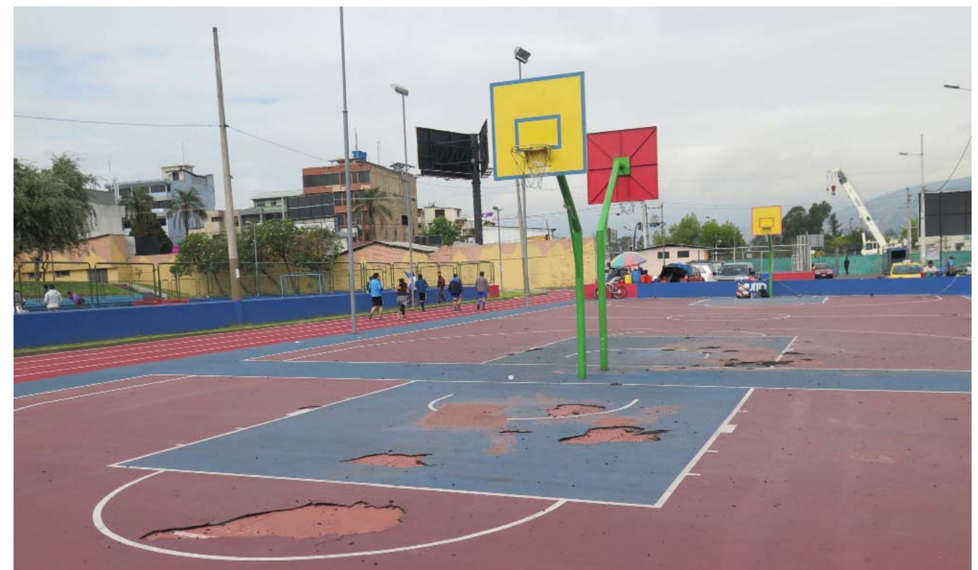
Cancha de Basket dañada
