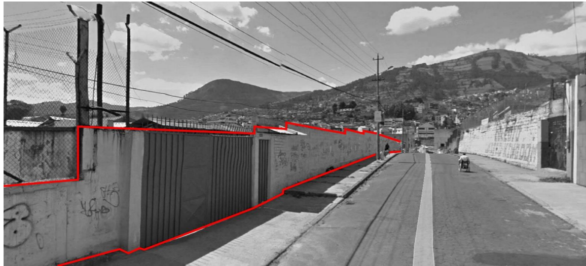
Figura 81 Foto actual del muro perimetral que rodea ATU
