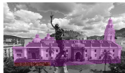
El Catedral Metropolitana de Quito es un edificio monumental, ubicado sobre una base de tiendas de pequeña escala
