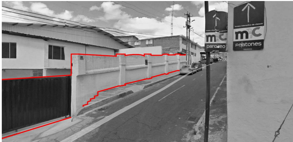
Figura 83. Muro de seguridad rodea lotes industriales en Chimbacalle, generando un entorno urbano inseguro
