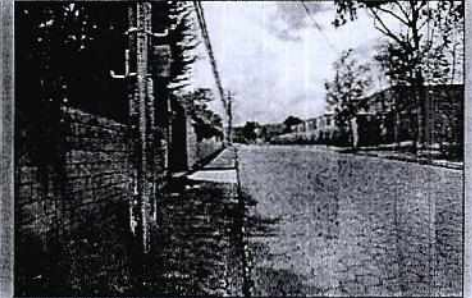
FIGURA No. 4 Via actualmente operativa y funcional.
