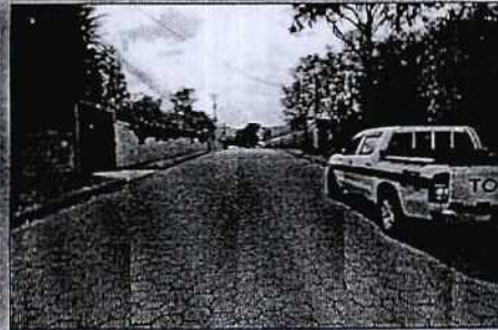
FIGURA No. 3 Capa de Rodadura Adoquinada.
