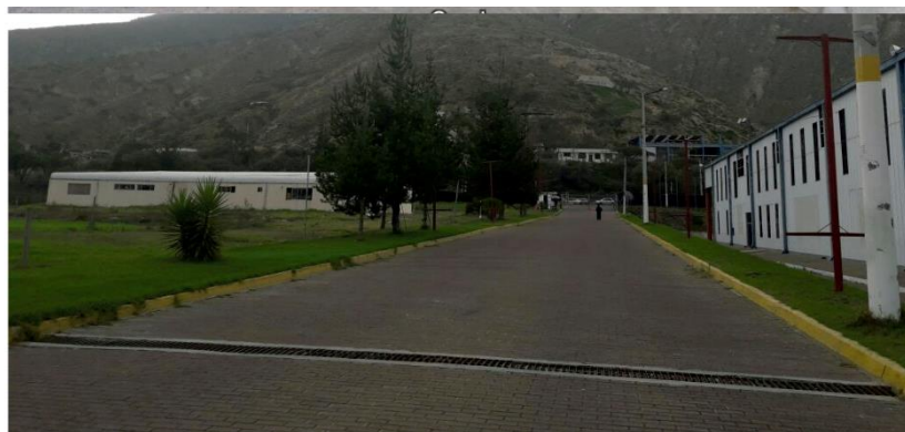
Imagen N°15: Vía existente de acceso al proyecto
