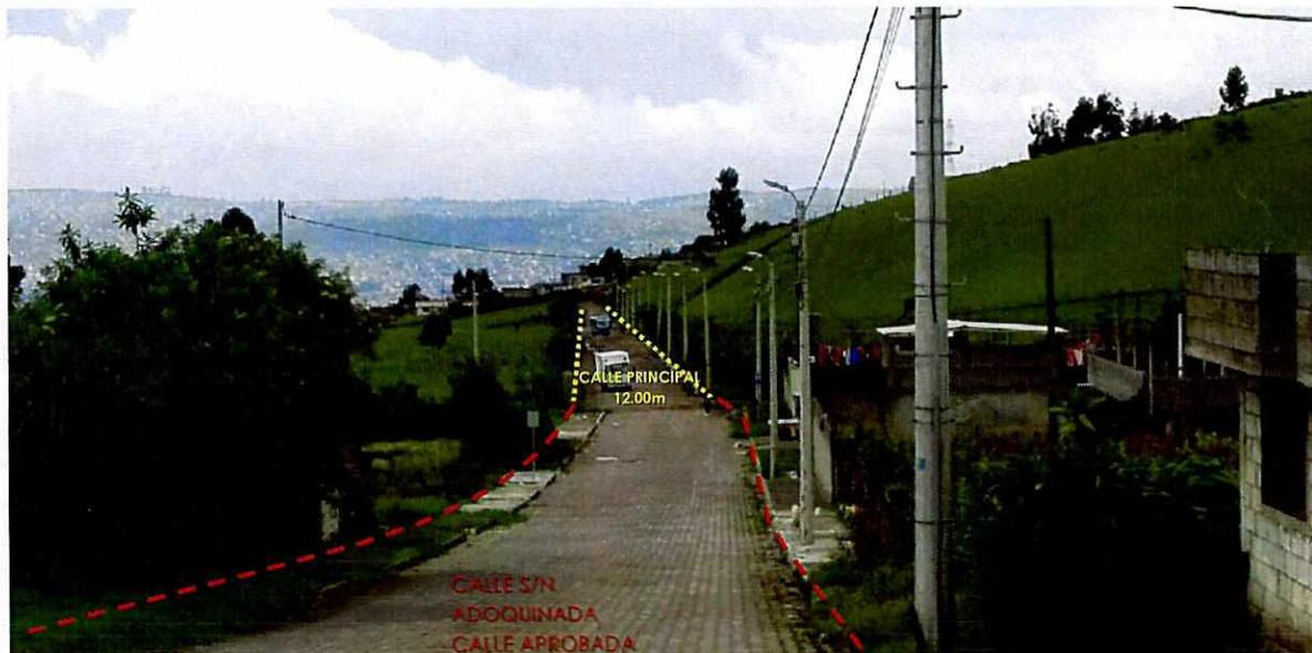
Como se indica en el gráfico (marcado con rojo), la calle esta adoquinada con una sección de 12.00 m y se encuentra aprobada; mientras que la calle para aprobación de trazado vial (marcado con amarillo) se encuentra en tierra y con la misma sección, para dar continuidad al trayecto.
