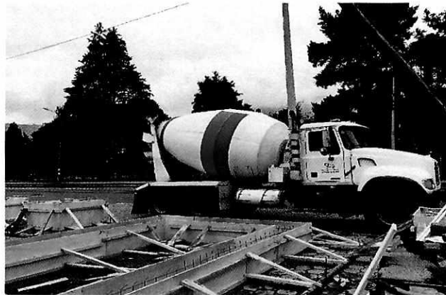
ENCOFRADO Y FUNDICION DE MACETAS Y JARDINERA
