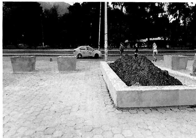
ENCOFRADO Y FUNDICION DE MACETAS Y JARDINERA
