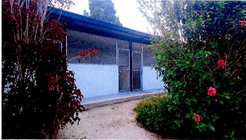
Construcción de gateras
