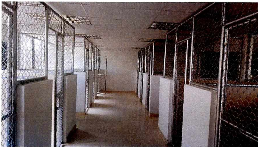
Construcción de caniles para recepción de animales
