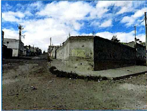
Fotografía 1: construcción de cerramiento de bloques.
