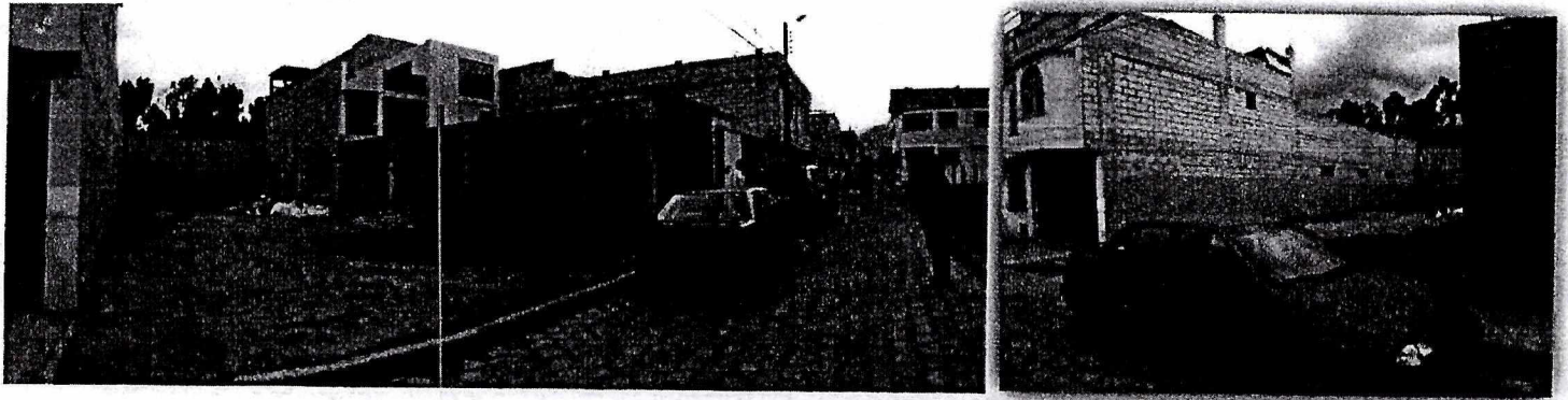
VISTA GENERAL DEL LOTE DESDE LA VÍA COLINDANTE (CALLE Oe7A) E INTERIOR.
