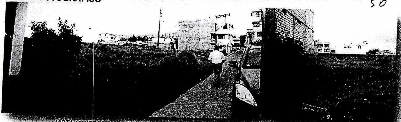
VISTA GENERAL DEL LOTE DESDE LA VIA COLINDANTE (CALLE S33G) E INTERIOR.
