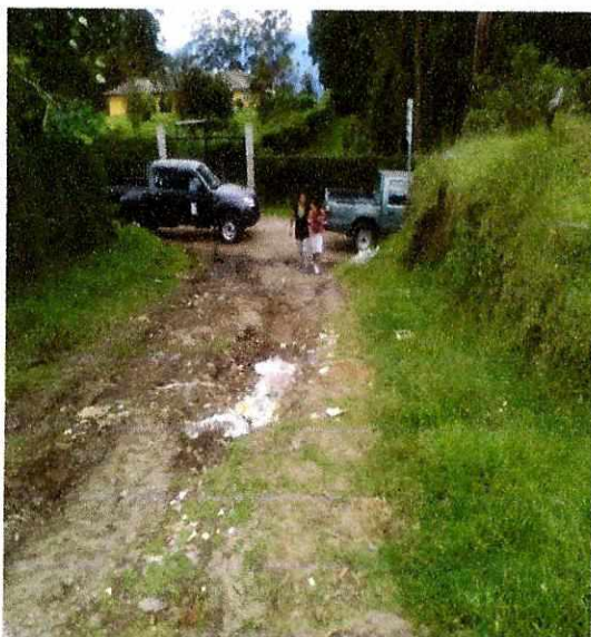
Inicio vía (tramo 1)
