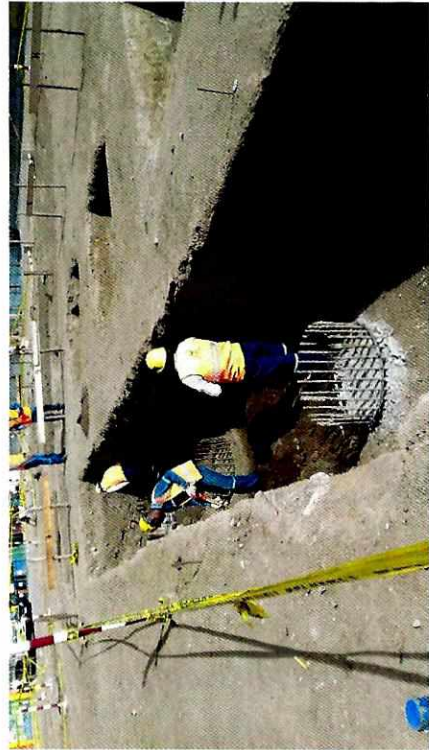
Fundición de Replántillos
