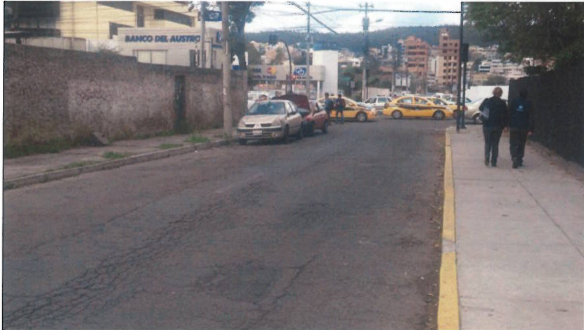
Villalengua y Av. Rio Amazonas (vista de Este a Oeste).
