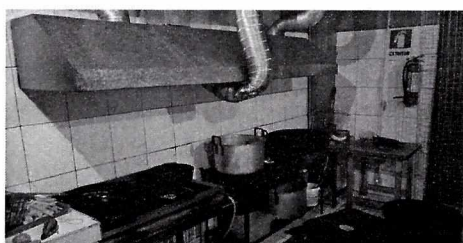
CAMPANA DE EXTRACCIÓN. HUMEDAD. SE COMPRUEBA FUNCIONAMIENTO COMO BAR /DISCOTECA
