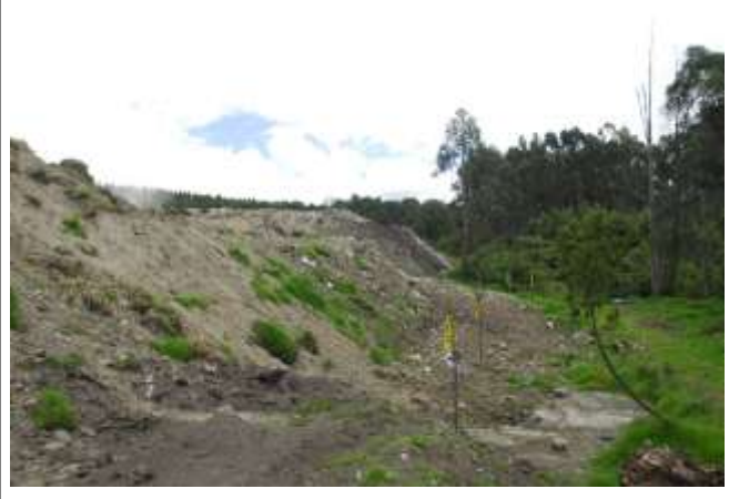
FOTOGRAFÍA N° A5-4: Los escombros se ubican de manera de talud junto a las áreas verdes. Sitio: Escombrera Troje IV Tomada por: Fernando Sornoza
