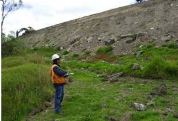
FOTOGRAFÍA N° A5-5: Escombros de diverso tipo son acarreados a las áreas naturales por escorrentía y gravedad en el momento de apilamiento de los mismos. No se maneja un control o zona de contención para los escombros. Sitio: Escombrera Troje IV Tomada por: Fernando Sornoza.
