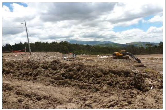
FOTOGRAFIA Nº 4: Vista parcial (sur-norte) de la escombrera Troje IV.
