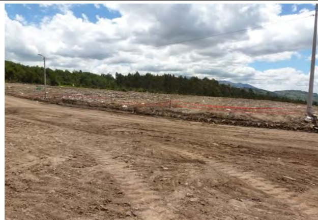
FOTOGRAFIA Nº 5: Vista parcial (sur-norte) de la escombrera Troje IV.
