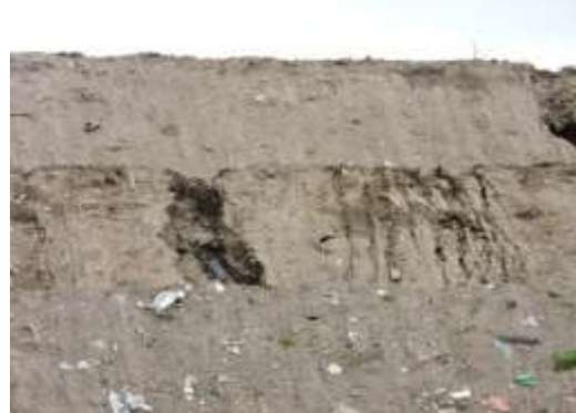
FOTOGRAFÍA N° A5-2: Talud final de la escombrera. Los desechos sólidos al filo del talud son acarreados sin control por la lluvia hacia las zonas naturales. Sitio: Escombrera Troje IV Tomada por: Yerka Sagredo.
