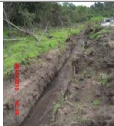
FOTOGRAFÍA N° A1-18: Cuneta construida para el desalajo de agua lluvia Sitio: Escombrera Troje IV Tomada por: Mireya T
