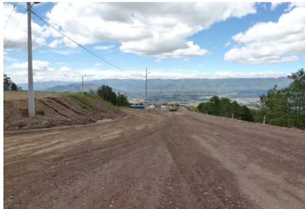
FOTOGRAFIA Nº 3: Ingreso a la escombrera Troje IV.
