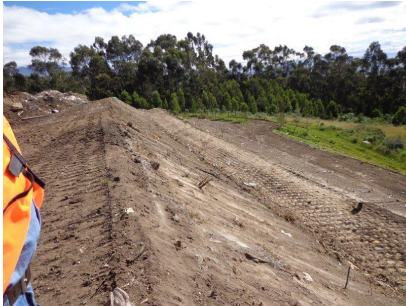
Foto 10: Conformación de taludes
