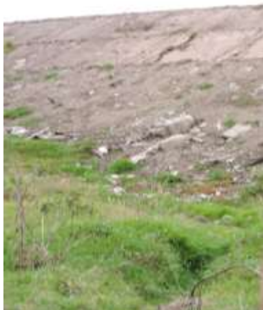
FOTOGRAFÍA N° A5-3: Escombros y desechos sólidos terminan por escorrentía, gravedad y falta de muro de contención, directamente en las áreas naturales. No existen canaletas para evitar acarreamiento de escombros en las áreas naturales. Sitio: Escombrera Troje IV Tomada por: Yerka Sagredo.
