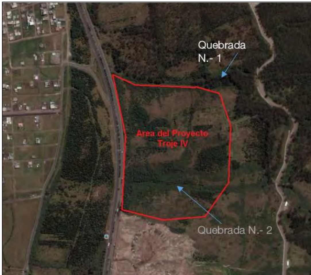
FIGURA N° 6-3: SITIO DEL PROYECTO ANTES DE QUE INICIEN LOS TRABAJOS DE CONSTRUCCIÓN DE LA ESCOMBRERA TROJE IV.
