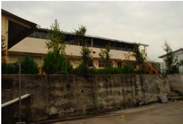
FOTOGRAFIA N° 39: Escuela Camino del Inca Tomada por: Fernando Sornoza Sitio: Barrio Músculos y Rieles
