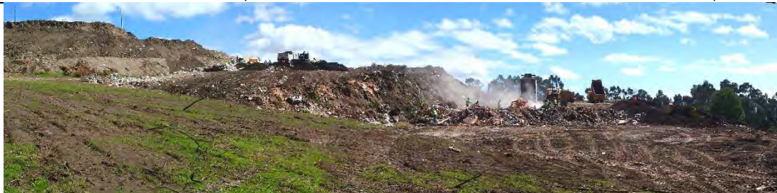
b. Pie de la escombrera, talud de más de 7 m de altura con una inclinación de 2V; 1H.
