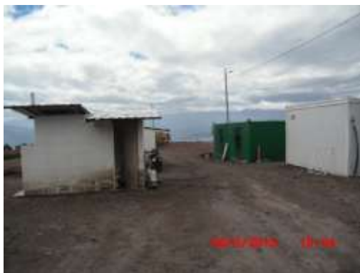
FOTOGRAFÍA N° A1-17: Servicios Higiénicos, cuentan con pozos sépticas Sitio: Escombrera Troje IV Tomada por: Mireya T
