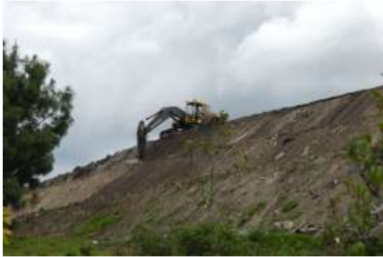
FOTOGRAFÍA N° A5-1: Disposición de los escombros sin área de amortiguamiento, lo cual causa que éstos por escorrentía o gravedad terminen en zonas naturales. Sitio: Escombrera Troje IV Tomada por: Fernando Sornoza.
