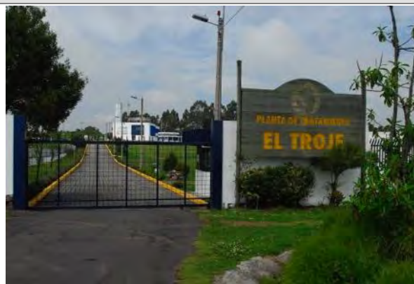
FOTOGRAFIA Nº 25: Planta de tratamiento El Troje, barrio Músculos y Rieles Tomada por: Fernando Sornoza Sitio: Barrio Músculos y Rieles
