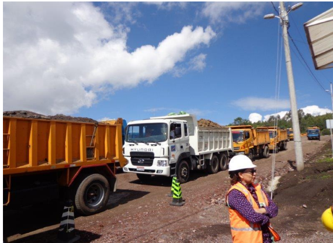
Foto 1: Acceso a la Escombrera Troje IV desde la Av. Simón Bolívar.
