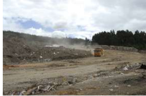
FOTOGRAFÍA N° A1-14: Trabajo de gestores conjuntamente con el ingreso del material Sitio: Escombrera Troje IV Tomada por: Mireya T
