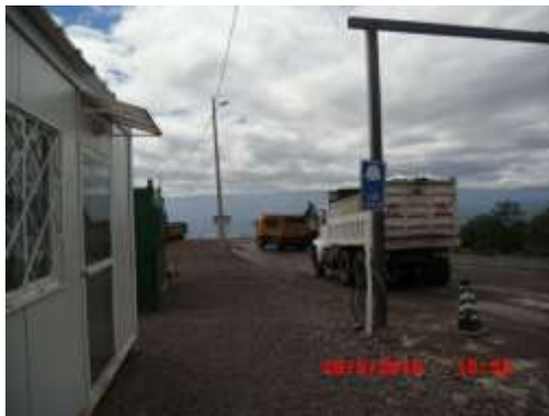
FOTOGRAFÍA N° A1-15: Oficinas y bodegas Sitio: Escombrera Troje IV Tomada por: Mireya T
