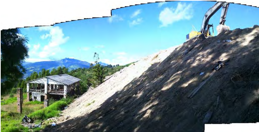
b. Pie de la escombrera, talud de más de 7 m de altura con una inclinación de 2V; 1H.
