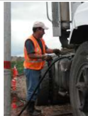
FOTOGRAFÍA N° A7-18: EPP utilizado para el traspaso de combustible por gravedad Sitio: Escombrera Troje IV Tomada por: Mireya T
