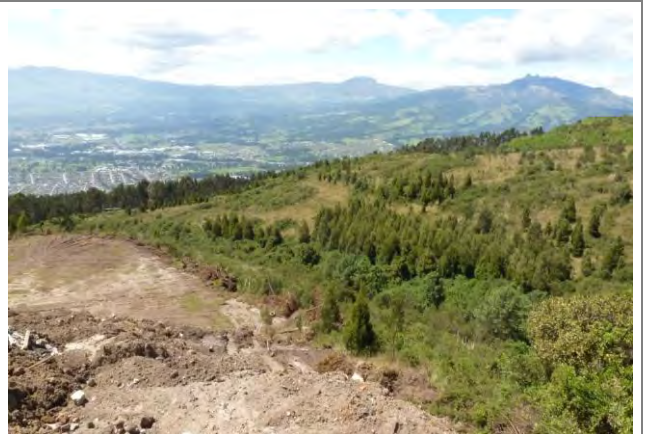
FOTOGRAFIA Nº 6: Vista de la sección sur (sin relleno) de la escombrera Troje IV.
